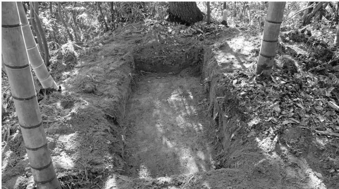
1. トレンチ 1 完掘状況(北から)
