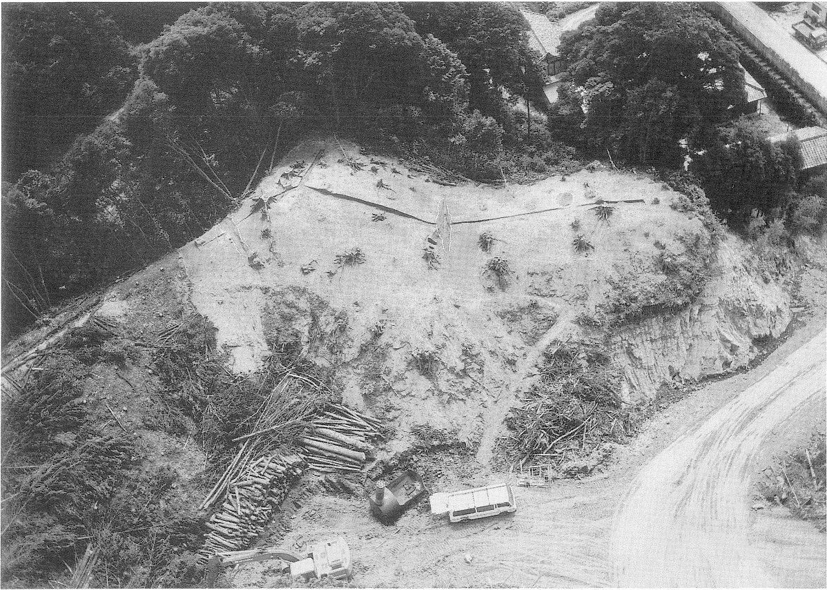
No 1・3 地点全景 (北より)
