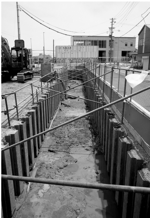
1 調査区全景（北から）
