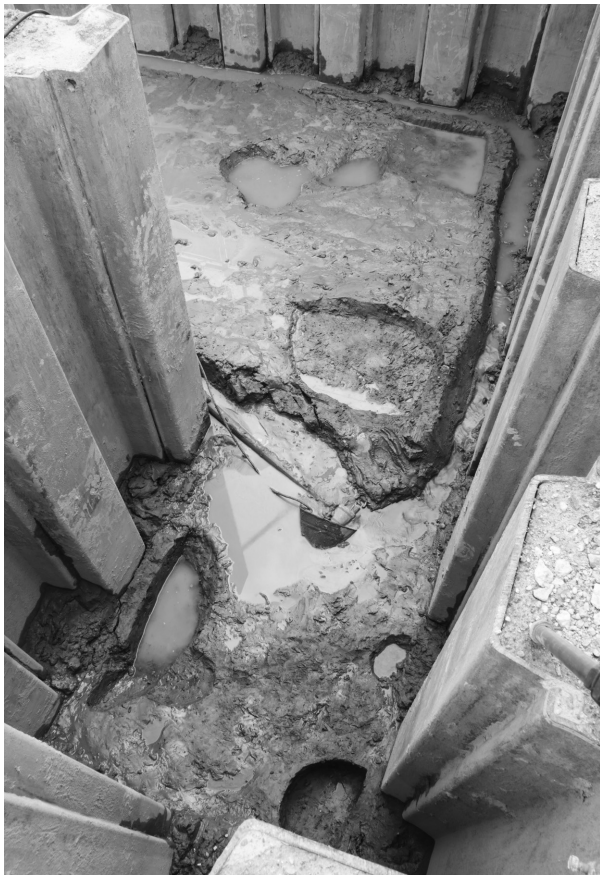
1 調査区北端部完掘状況（東から）
