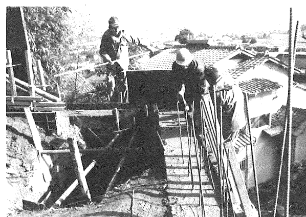
6 擁壁コンクリート打
