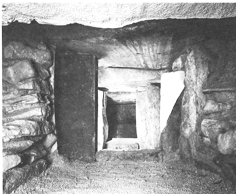
7 羨道より奥室を見る 左主 袖石は新補材 右主 袖石は補修材
