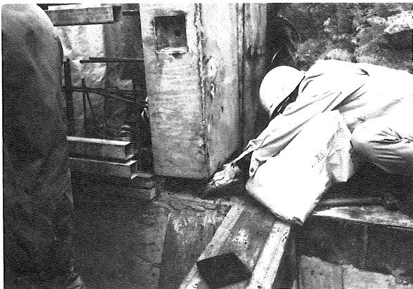
17 基礎アンカー樹脂モルタル充てん
