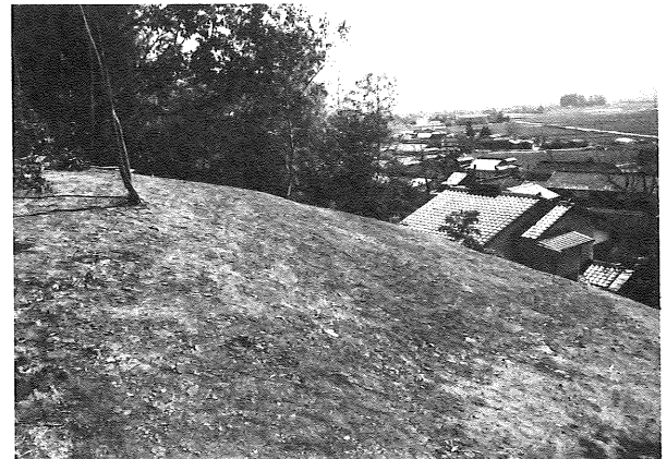
34 墳丘盛土完了
