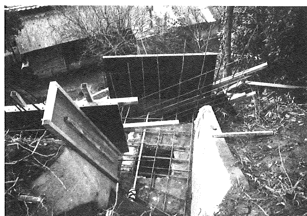
5 擁壁剪断キー配筋
