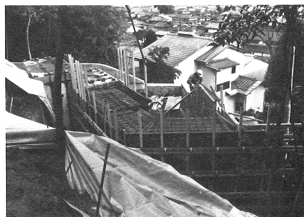
23 現場打ち部天井配筋
