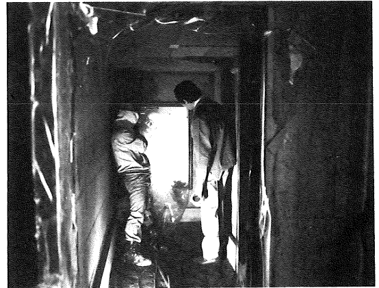
28 内部ウレタン吹付け
