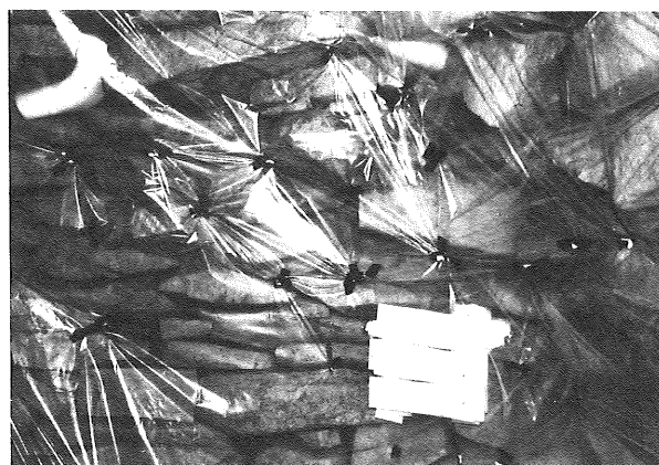
2 奥室壁面保護
