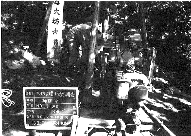
10 ボーリング試験
