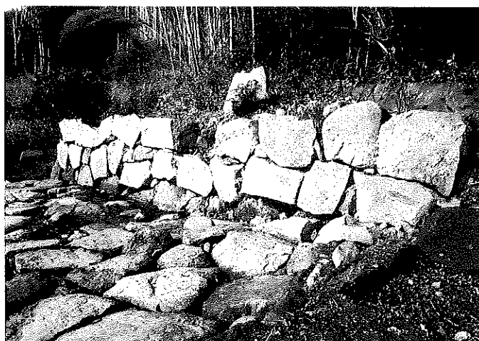
吐井手石積導水堤 右岸 (東から)
