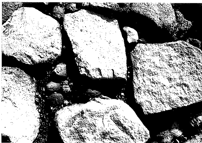
吐井手護床石敷の矢穴痕 (西から)
