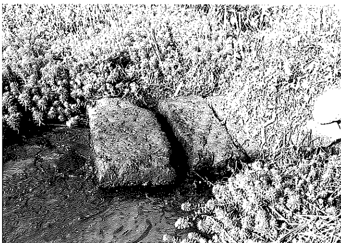
浮田下ノ池からの底樋出口 (東から)
