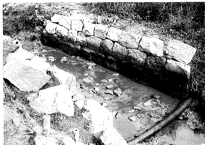
下流石積 横木検出状況 (南西から)
