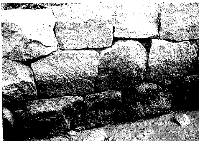
下流石積に残る矢穴痕 (北から)
