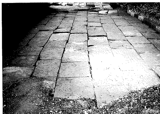
吐井手板石敷の漆喰 (北東から)
