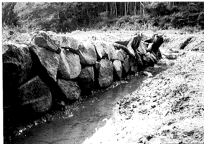
吐井手石積導水堤近景 (北東から)
