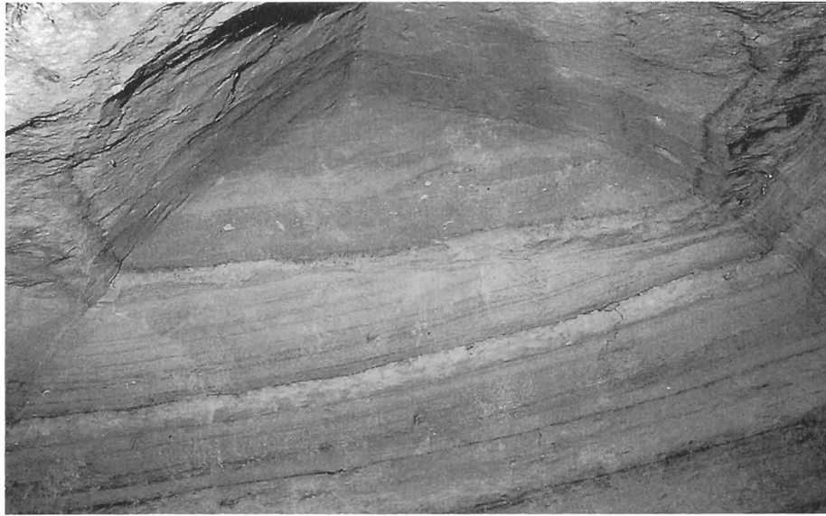
A群6号墓 奥壁天井周辺の状態
