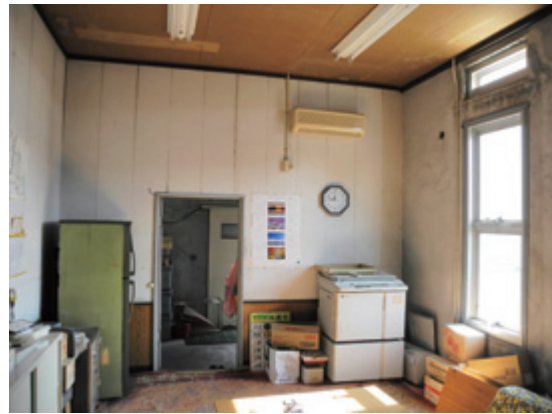
2階 商店会室東を見る
