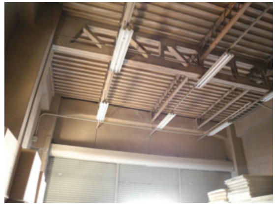
1階 正面シャッター上方に大梁が架かる
