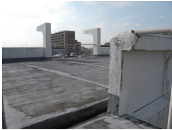
屋上への上がり口 手前に排水溝が見える
