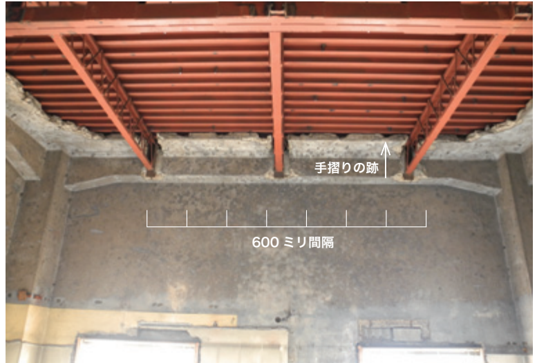
南面の壁を見上げる 回廊の幅、手摺り子が600ミリ間隔で立っていたことがわかる。回廊縁の厚さは120ミリ。 壁面に間接照明を取り付けた痕跡は確認できない。 2階の床を造るデッキプレートは回廊の上にのせられている。
