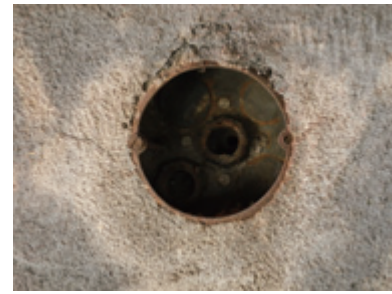
柱面コンセントの痕跡 直径 80 ミリ
