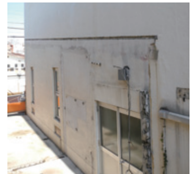
西面、南から見る。消防署車庫の痕跡
