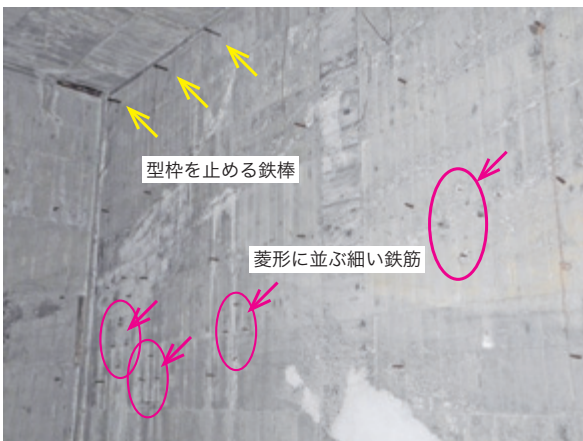
壁の一部には、細い鉄筋が規則的に並ぶとともに、一部は菱形に配置されて突出する。
