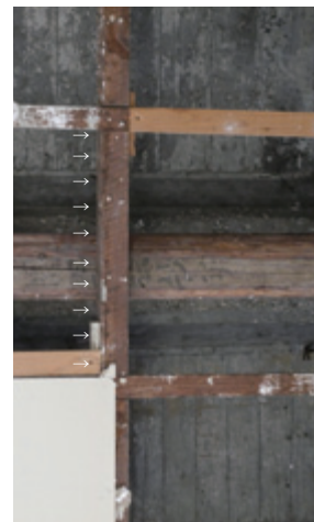
前身天井の留め釘の跡は、1.5寸間隔とたいへん狭い。(→で位置を示す) 現状は同間隔に釘4本程度で留める。
