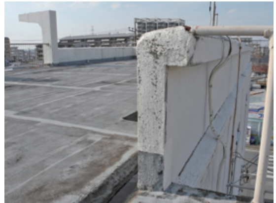
屋上 階段上がり口に見るパラペット断面
