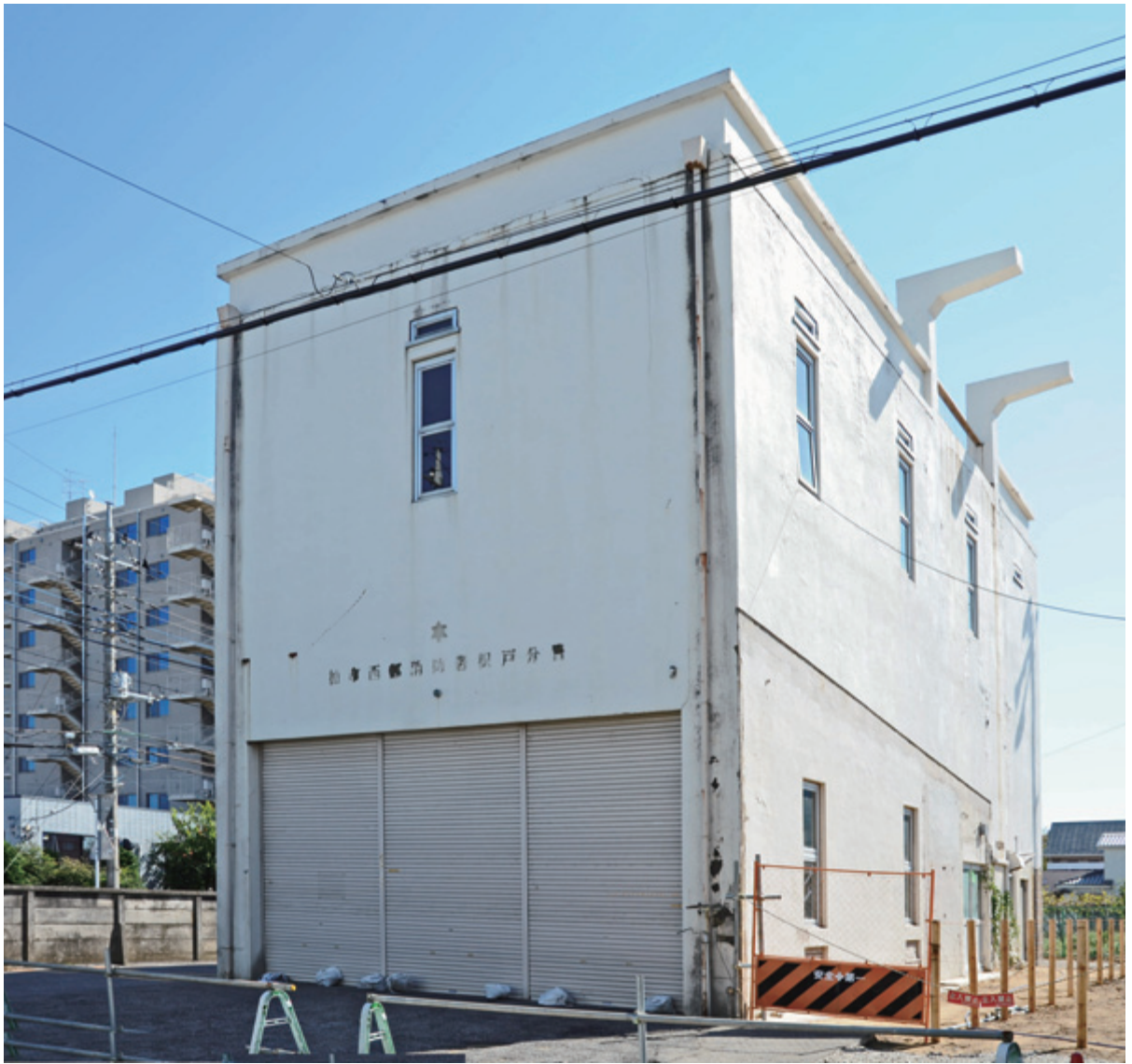
外観 北西から見る
