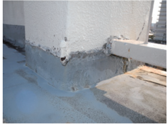
屋上 起重機支柱足元に残る肘壺金物。各支柱の内法下方と腰高（現在の柵ぐらの高さ）に残る
