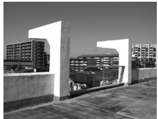
屋上西面にはクレーン支柱が立つ
