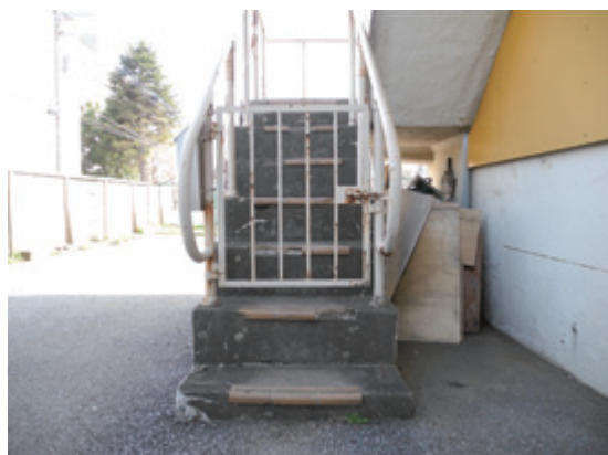
階段 上がり口正面には扉。階段1段目が埋もれている
