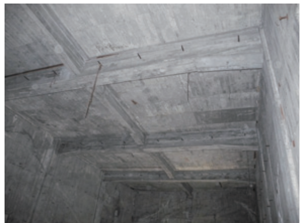
壁には表面仕上げがされておらず、コンクリート型枠を緊結した鉄棒が壁面から突出するままだに残る。鉄棒の一部に残る針金や縄の断片より、天井造作を設けずに映写幕を吊したことがうかがえる。
