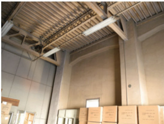
1階 壁沿いに大梁が架かる
