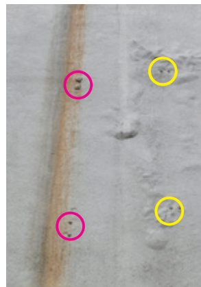
起重機支柱の上端に残るボルト切断跡から、横架材や控え(か)の状況を推定(架かる材の向きを加筆)
