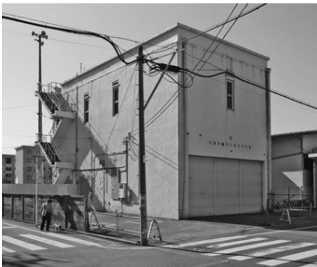
北東から見る 東壁に取り付く外階段で屋上にあがる
