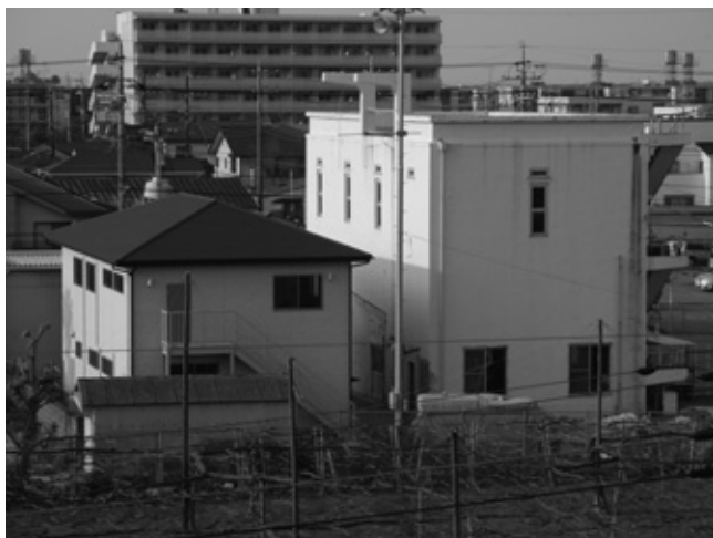
旧分署を南から見る
