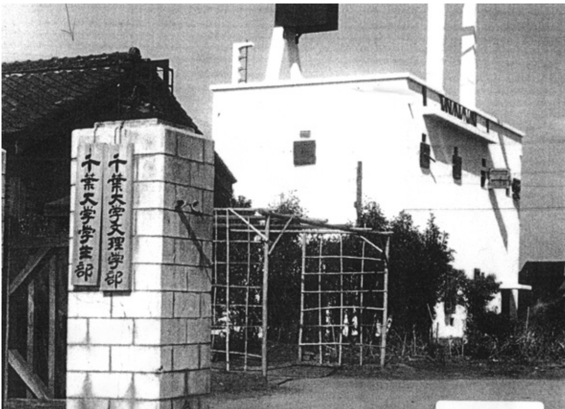
千葉大学文理学部正門から見る照空予習室。1950年代初期 建物の詳細がわかる。屋上の南西隅に用途不明の突起物が見える。
