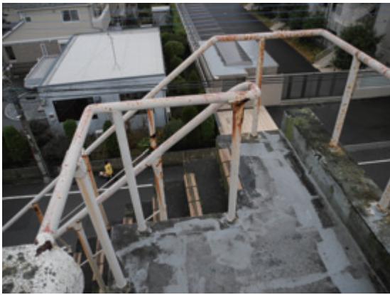
屋上への上がり口 踊り場
