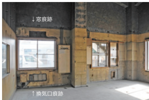
1階 消防署として利用するために、開口部は大きくされてアルミサッシが建て込まれていた
