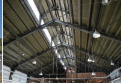
砲廠 小屋組も鉄骨からなる
