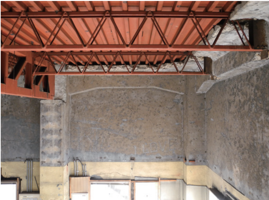
東面の壁 2階を設ける時に鉄骨梁を取り付けた位置では柱の表面がはつられたために、柱上方の梯子の取り付け痕は失われている。 壁面には小さいボールのようなものが当たった跡が全面に無数にあり、高射砲連隊及びその後に入った軍隊によって本建物内での演習によってついたものか。
