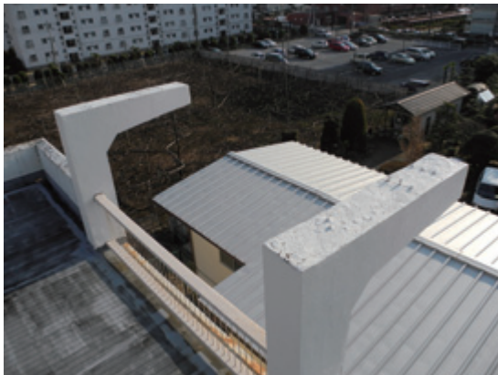
屋上 起重機支柱上端に残るボルト跡
