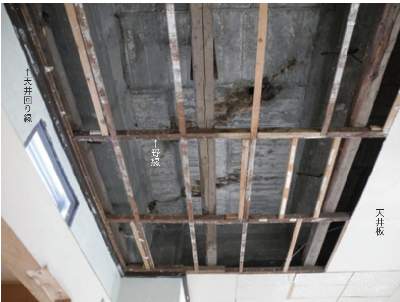
2階の天井造作は、当初材。現在の天井板は、後補の吉野石膏のタイガーボード。 野縁には、前身天井の留め釘跡があり(右図)、帆布取り付け跡と思われるが、布類の断片は確認できず。 壁面については、天井回り縁の上方はコンクリート打ち放し、下方のようにモルタル塗仕上げはない。
