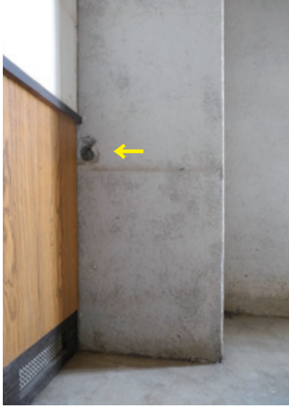
2階西壁南から2本目の柱東面 手摺り痕跡（現床面は後設）
