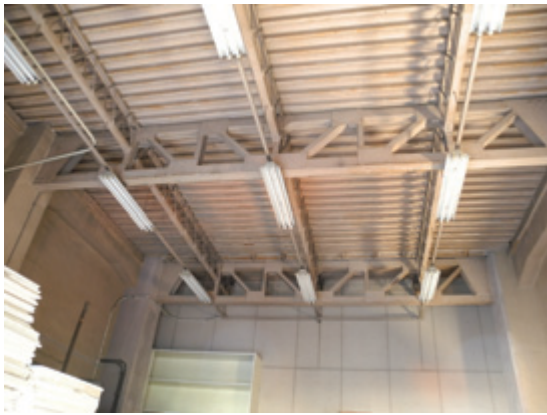
1階 天井トラス
