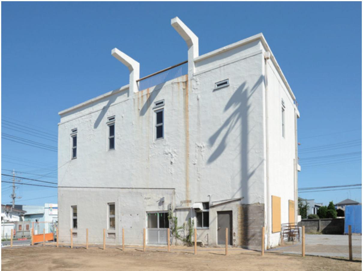
測遠器訓練所 起重機で屋上に測遠機をあげて、遠方の航空機や高い構造物の位置を測定する訓練をした。 写真 小林正孝 西面全景 屋上には起重機支柱が立ち、壁面に起重機昇降レール支持材の取り付け痕跡が残る。 隣地の消防署別棟解体後、高野台町会集会所建設準備中（2015年春撮影）
