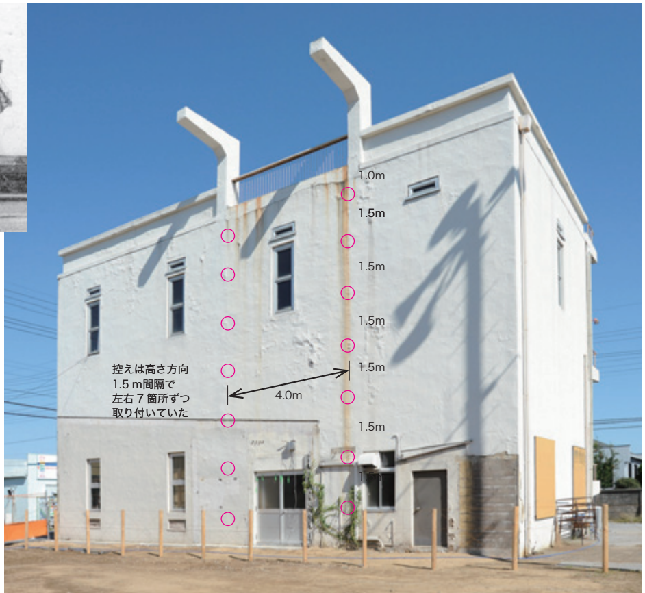
高射砲第1連隊(浜松) 照空予習室に見る起重機 ガイドレール支持材
