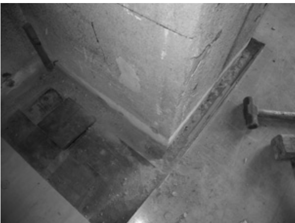
1階南側では、現在の床面の135ミリ下にコンクリート叩きと高さ200ミリの幅木が確認された。
