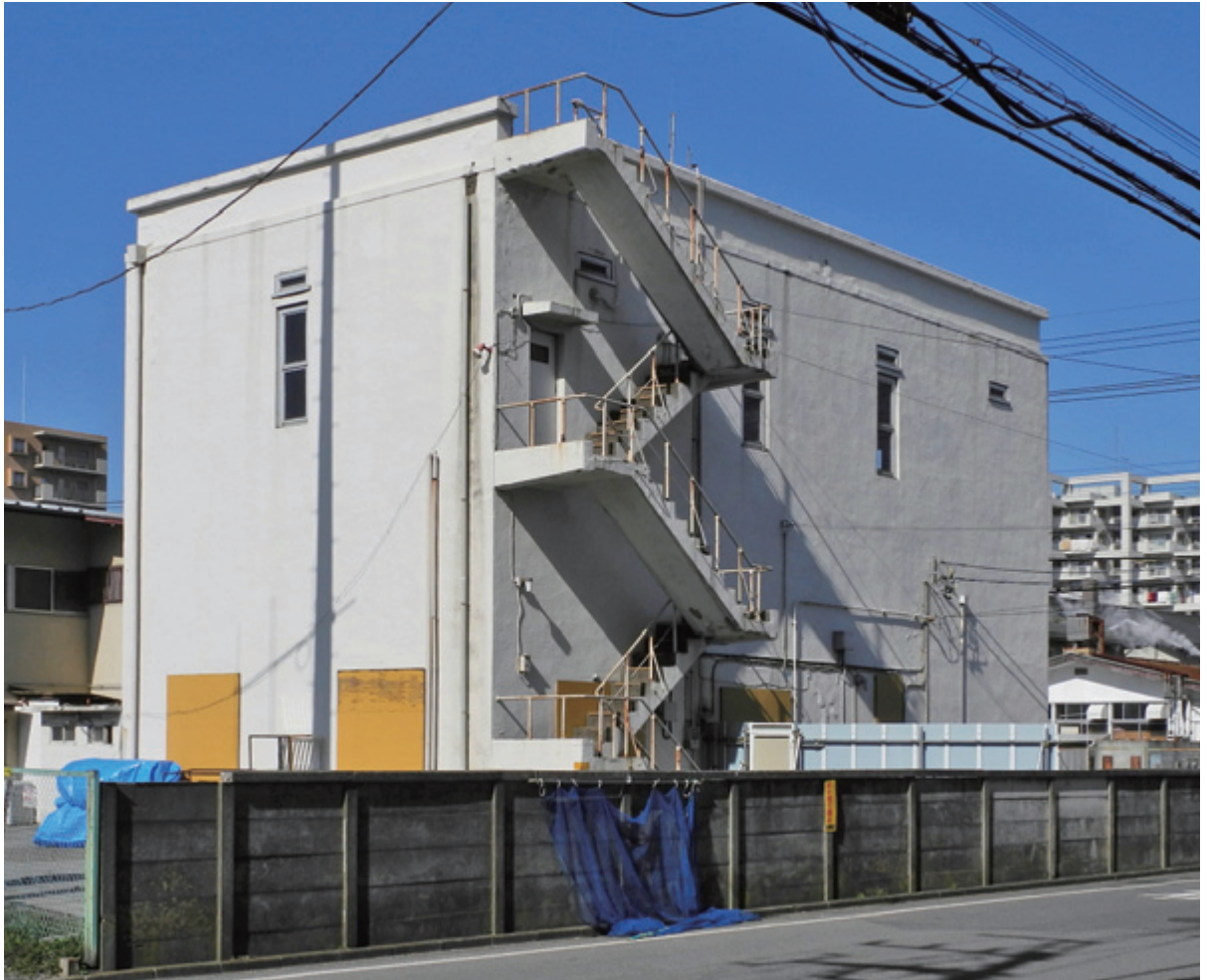
外観 背側面 南東から見る
