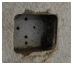
2 階出入口脇 (右) 照明及びスイッチ痕跡 (左) スイッチ痕跡詳細
