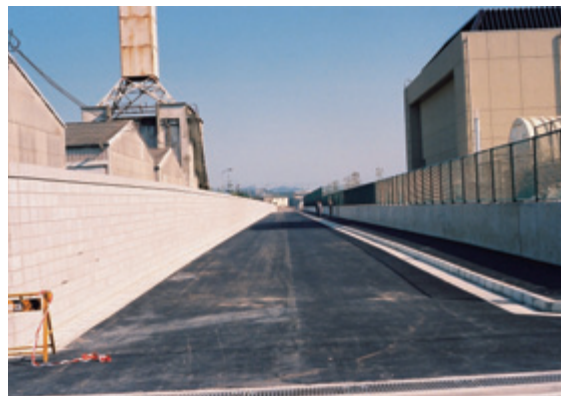
道路を工場敷地の東側に移した1985年に撮影 左図共ハリマ化成所蔵
