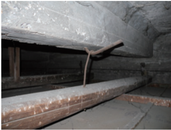
小梁下に突出する鉄筋に野縁受けが取り付けく。 この下に野縁を打ち、天井板を張る。
