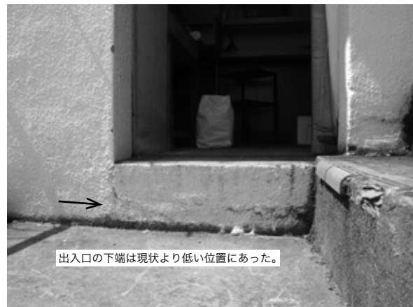
階段踊り場から回廊への出入口は、下端が低かった痕跡がある。現在の2階床は回廊の上に載せられ、高くなっている。
