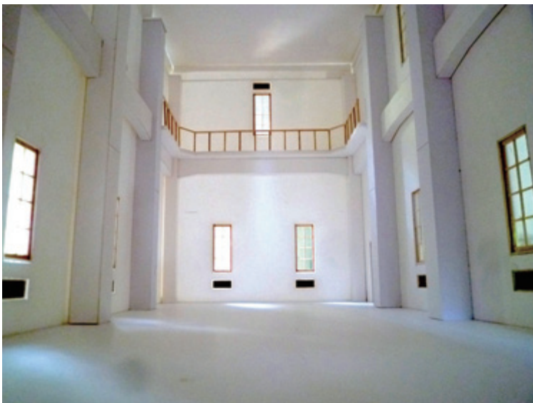
高射砲第2連隊照空予習室 復原模型 縮尺：1/25 正面出入口から室内を見る。当初室内は吹き抜けて、奥に回廊が廻されていた。
