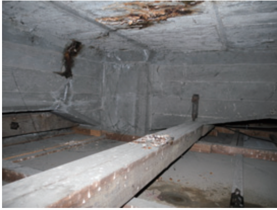
北東隅柱に大梁が2方向から架かる
