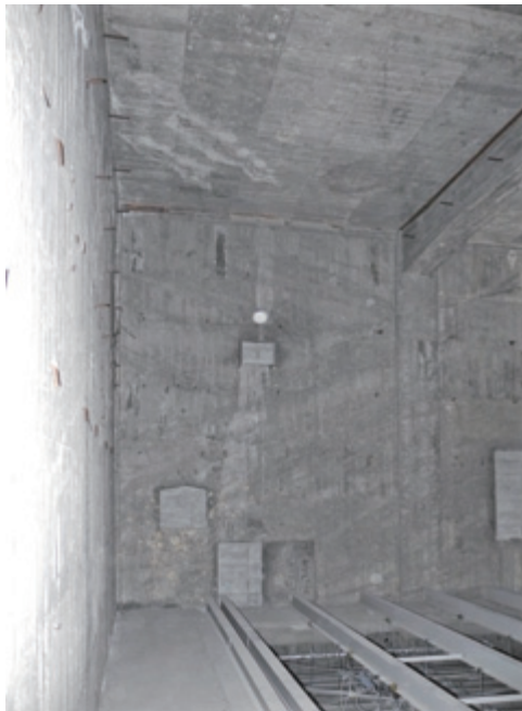
室内2階西壁には、右図に見る突出部に続く開口部を埋めた跡が残る。画面左端は、投影機用開口部か。
