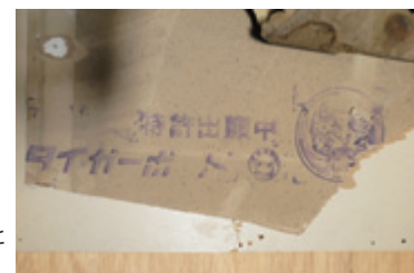
2階の天井造作は、当初材。現在の天井板は、後補の吉野石膏のタイガーボード。 野縁には、前身天井の留め釘跡があり(右図)、帆布取り付け跡と思われるが、布類の断片は確認できず。 壁面については、天井回り縁の上方はコンクリート打ち放し、下方のようにモルタル塗仕上げはない。
