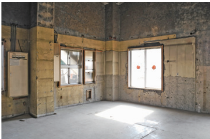
1 階室内南東隅 内装材を撤去すると、消防署に最初に改装された当時の壁仕上げが表れた。写真は風呂場と洗面所。この黄色の仕上げは、外壁仕上げの下に残る黄色い仕上げと時代が揃うと思われる。
