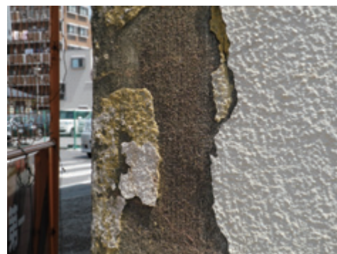
外壁破損部より、仕上げの変遷がわかる。モルタル塗刷毛引き（当初）→黄色吹き付け→白色吹き付け→白色ペンキ塗（現況）
