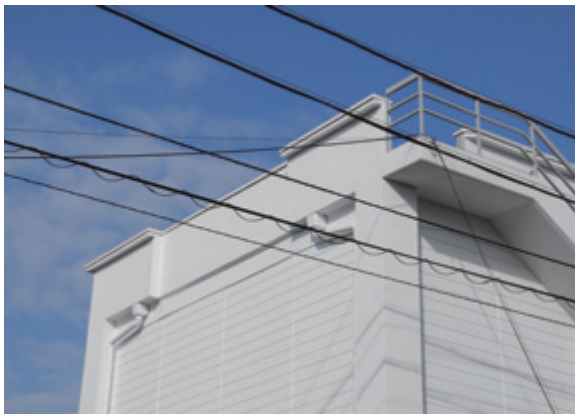
南面には、起重機からの上げ下ろしのために開放されていた パラペットを埋めた跡がある
