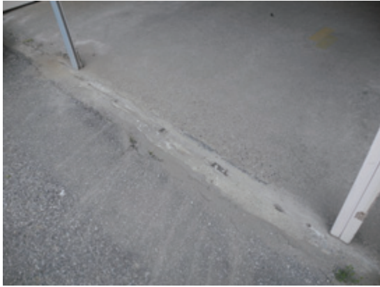
正面シャッター足元に埋め込まれて残る金物は、当初吊り戸の敷居か。
