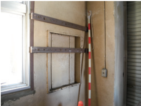
1 階西壁 スイッチボード跡
