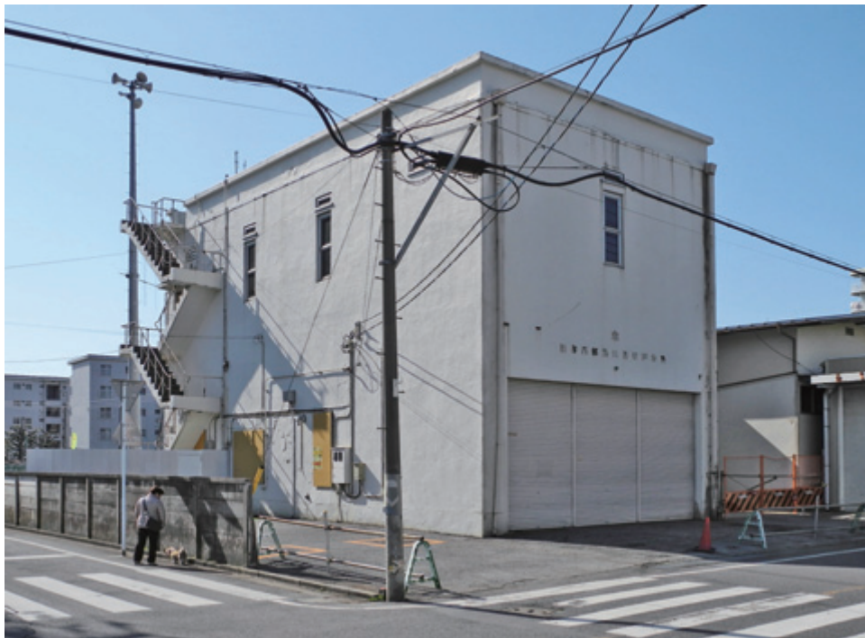
根戸の光景 旧柏市西部消防署根戸分署／高射砲第2連隊照空予習室
