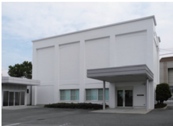
西面 玄関を新たに設け、1階窓は拡張されている
