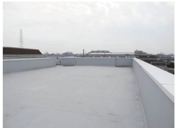
屋上から左図の内側を見る
