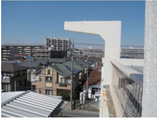
屋上 起重機支柱側面
