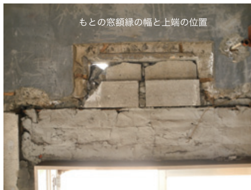
1階 室内では、拡張された窓開口部上方に、額縁を取り付けた痕跡が残っていた。コンクリートに木片が埋め込まれている
