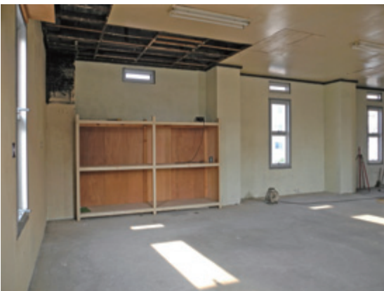
町会室 東を見る (北東隅の天井を調査のために解体後)
