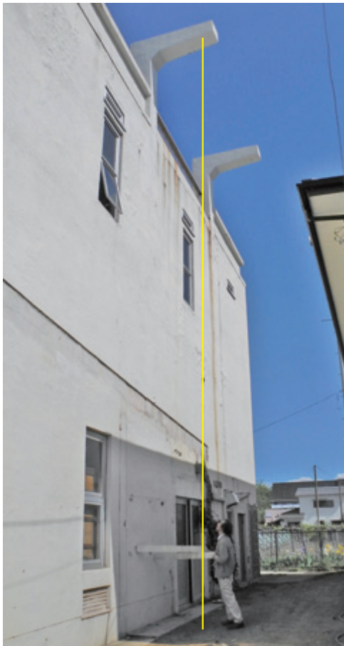
起重機ガイドレール位置検討状況(ガイドレールを加筆)
