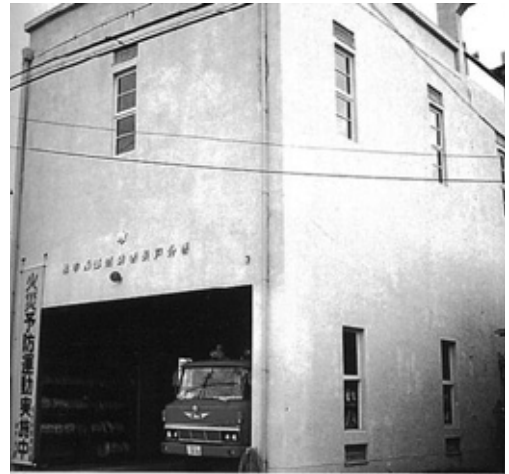
アルミサッシに更新される前の消防署の窓廻り。 上げ下げ窓は木製か。各窓には横棧が1本入る。
