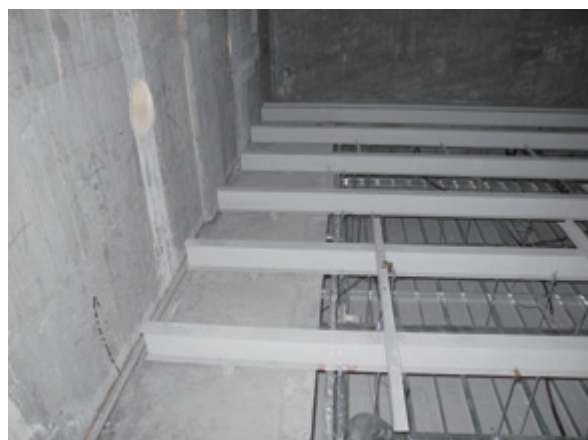
回廊 内周には手摺りを撤去した跡がある。レールのような「映写幕」移動装置の痕跡はない。
