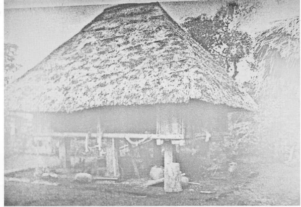
第12図 東京都八丈島の民家
