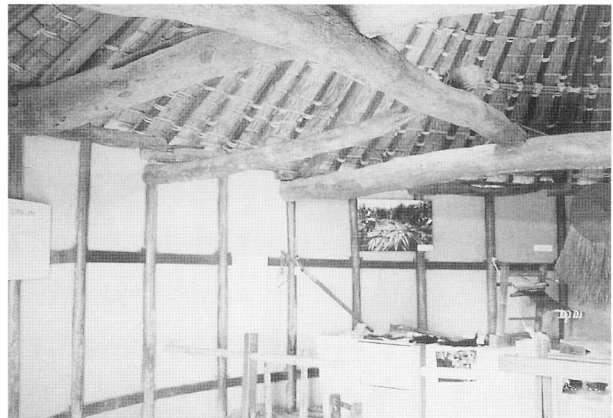
第15図 砂糖しめ小屋の小屋組み
