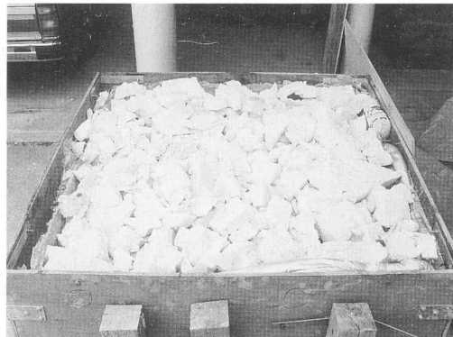
写真47 裏面に細切ファイバーを詰める(南)
