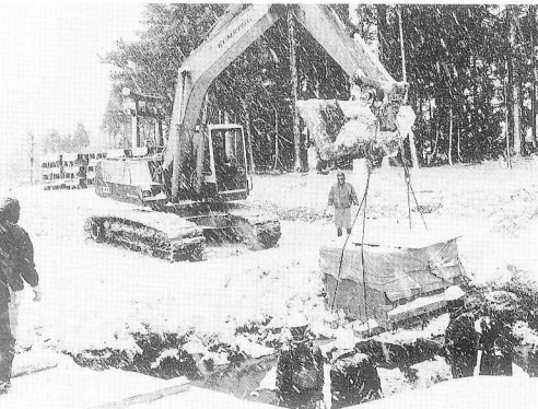
写真21 吹雪の中での足跡の吊り上げ（南）
