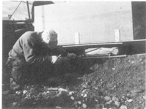
写真20 底面の崩落防止のためのジャッキも使用
