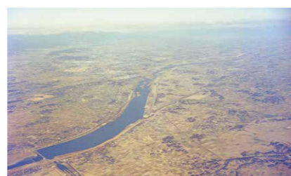
▲ 利根川（利根川大堰）
