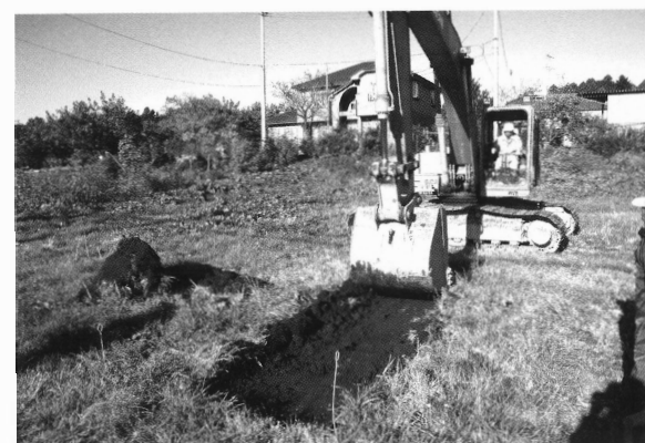
7 表土掘削状況
