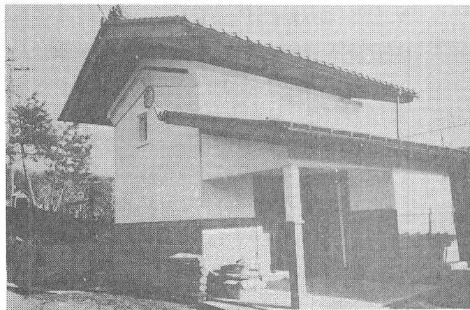
〔写真3-22〕土蔵造りの完成
