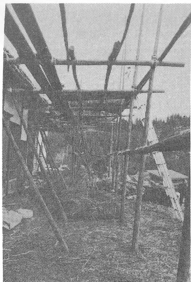
〔写真1-5〕足場のようす
