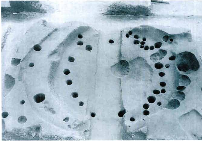
SI25J住居 構築時全景（北から）
