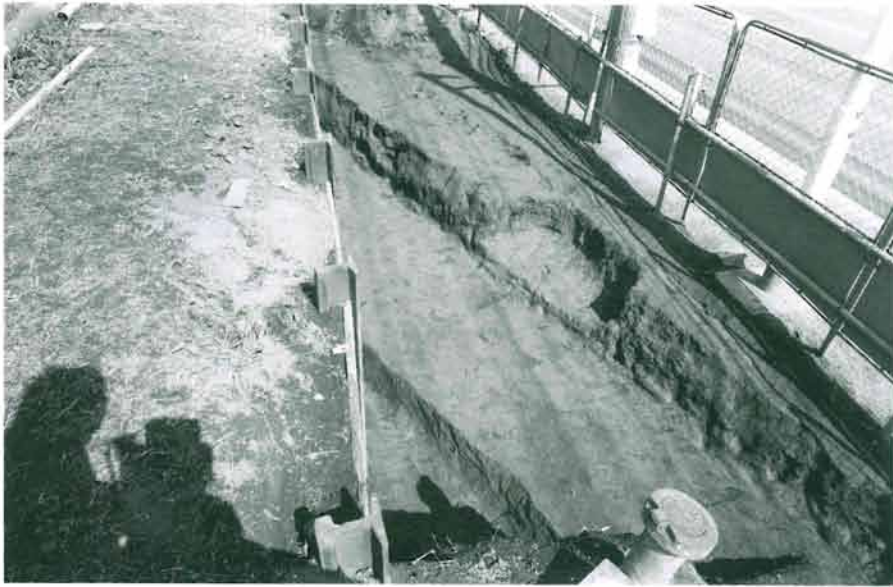
1. Cトレンチ歴史時代SD1・2・3溝跡・SK7土坑全景（南から）
