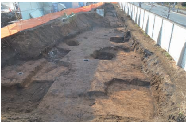
10-5 B-6区古代確認面調査終了全景（北側東から）
