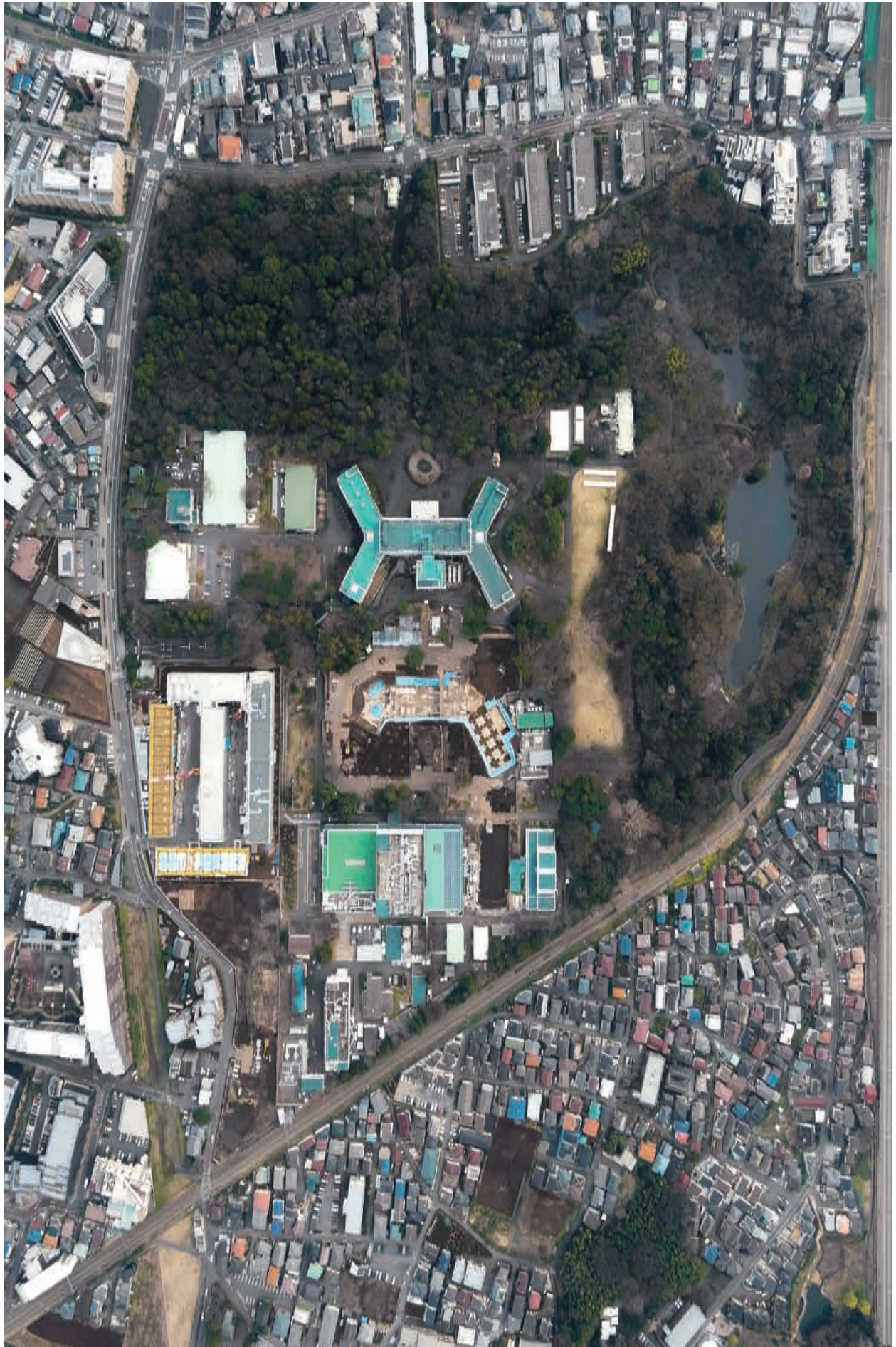
2-1 調査区俯瞰（上が北）
