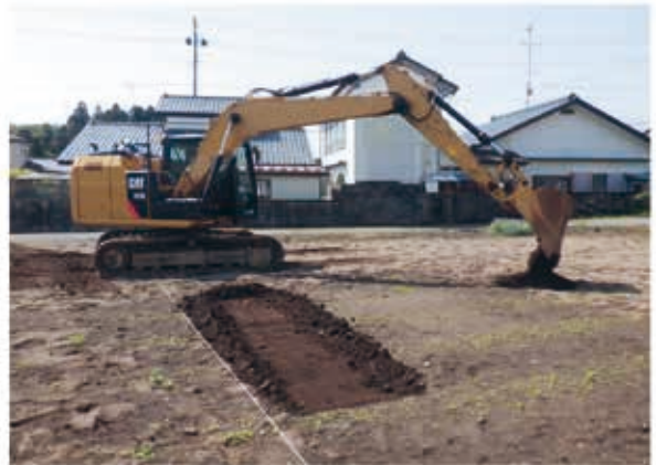
写真 46 重機掘削状況
