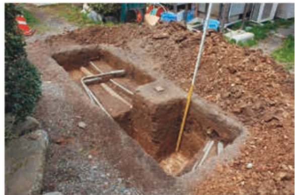
写真 198 3 T 調査状況
