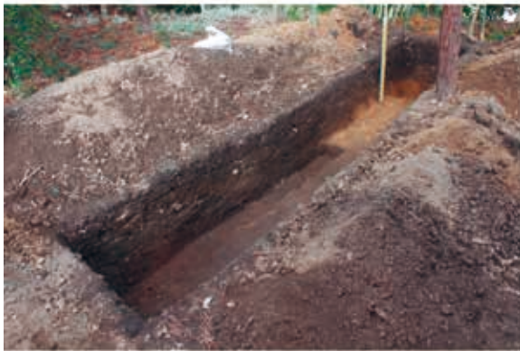
写真 207 7 T 調査状況
