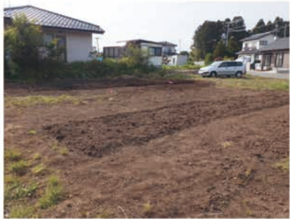
写真14 埋め戻し状況
