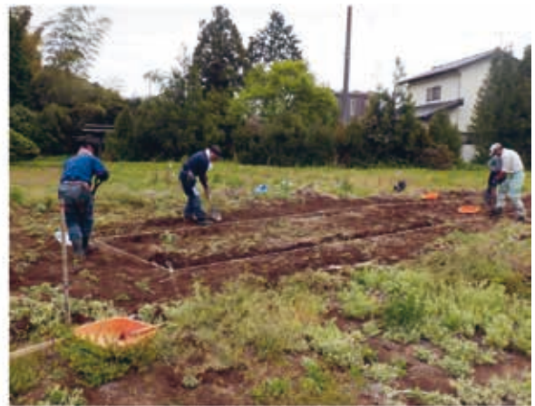
写真 36 人力掘削状況
