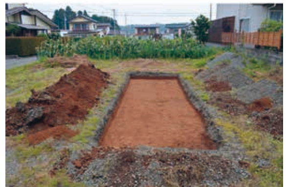
写真74 1-T調査状況
