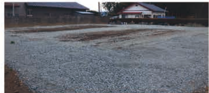
写真 158 埋め戻し作業終了状況
