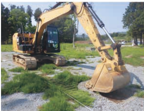
写真 28 重機掘削状況
