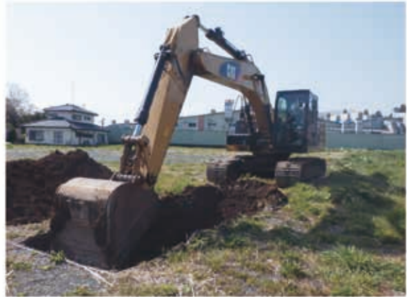
写真2 重機掘削状況
