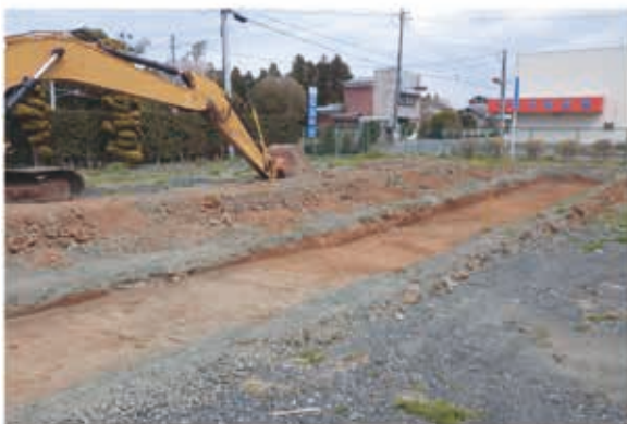
写真5 5T調査状況
