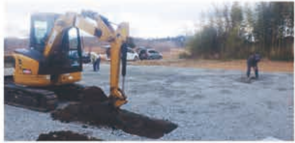
写真 152 重機掘削状況
