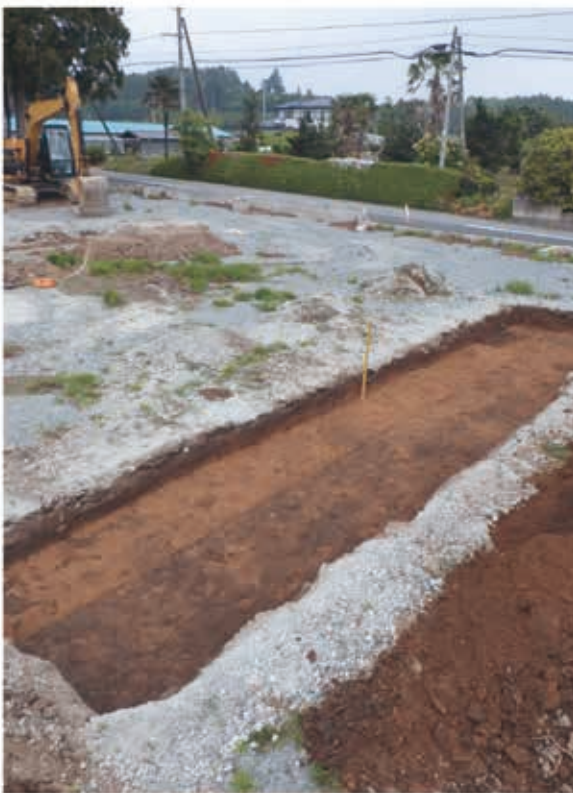
写真 33 2 T 調査状況
