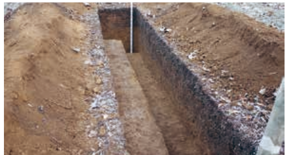
写真152 6 T 調査状況
