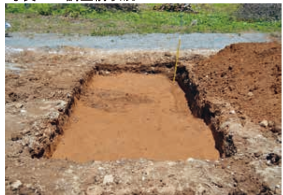
写真56 1 T 調査状況
