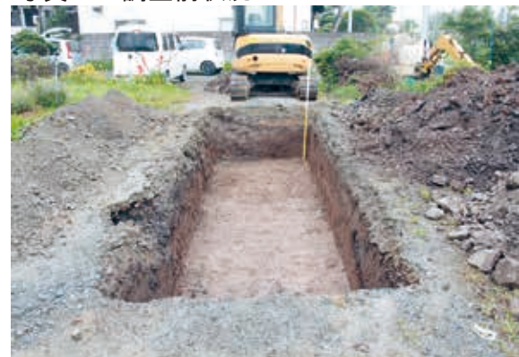
写真59 1 T 調査状況
