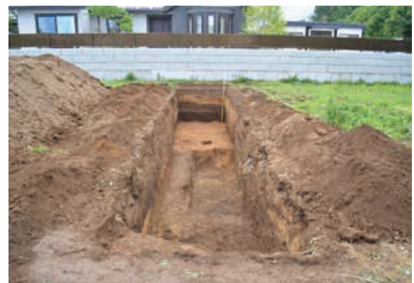
写真40 2 T 調査状況
