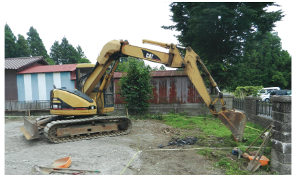
写真22 重機掘削状況
