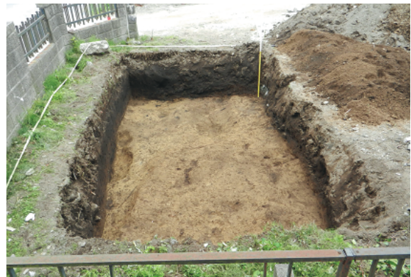
写真24 1 T 調査状況
