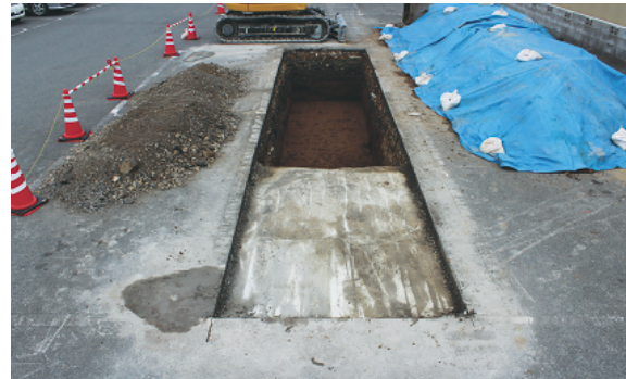
写真30 2 T 調査状況
