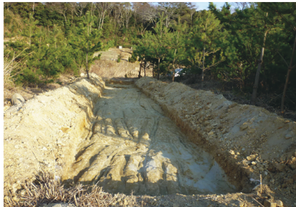
写真 45 4T 調査状況
