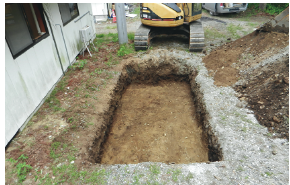
写真23 2 T 調査状況
