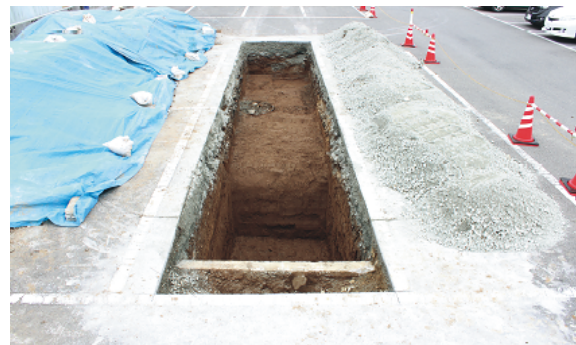
写真29 1 T 調査状況
