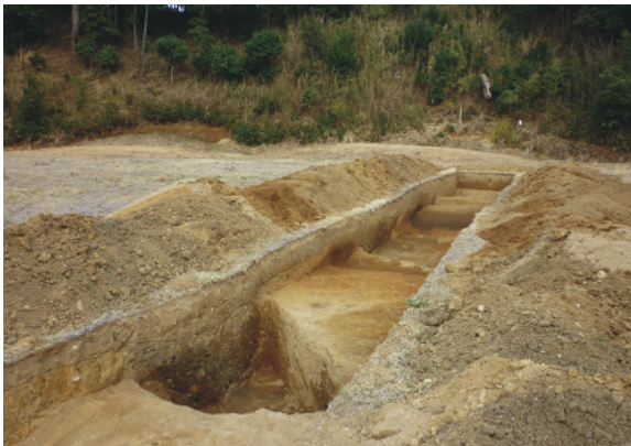
写真 44 2T 調査状況
