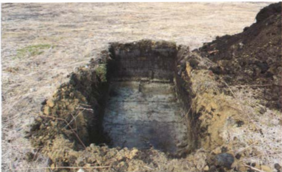
写真 266 A区 2 T 調査状況
