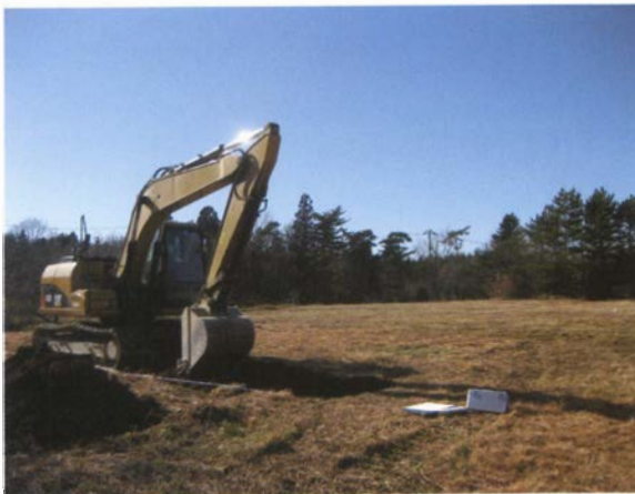
写真 102 重機掘削状況
