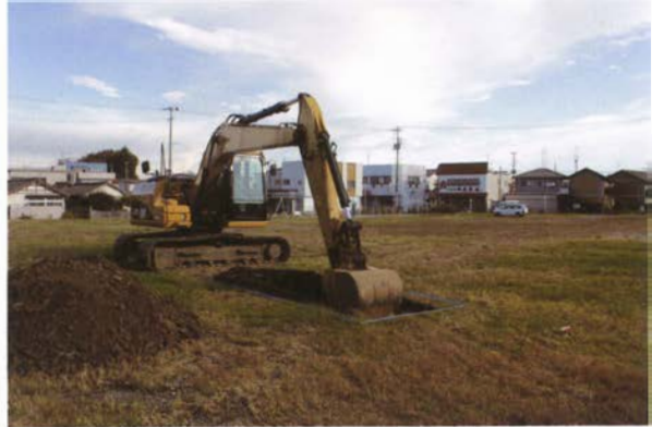
写真 232 表土除去作業
