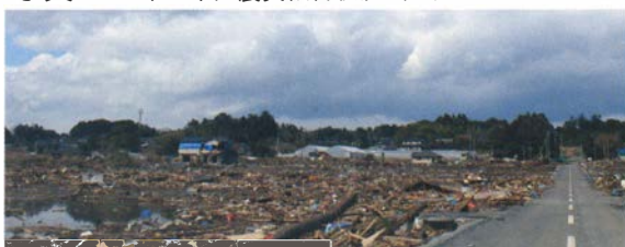
写真4 東日本大震災被災状況(4) (鹿島区南海老付近)
