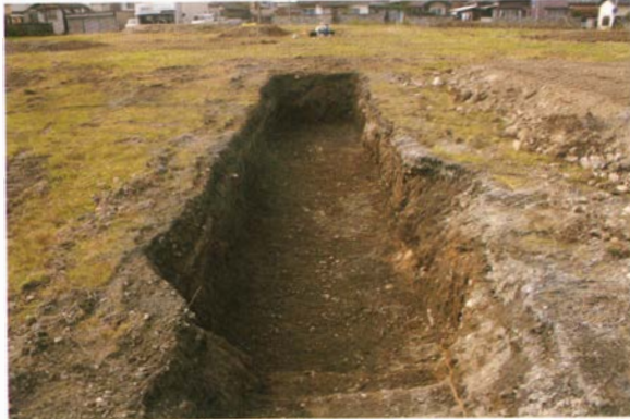
写真 236 4 T 調査状況
