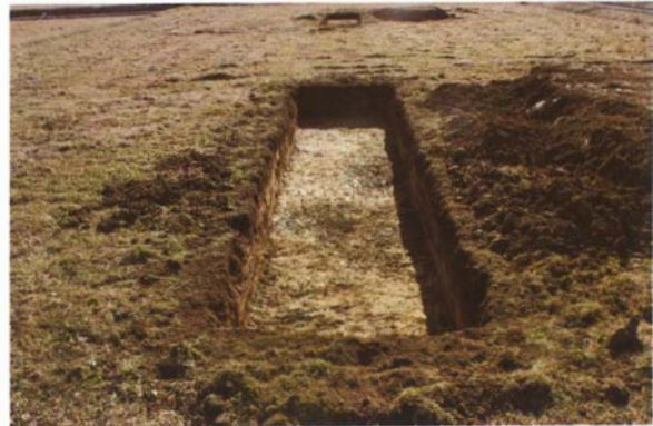
写真 188 2 T 調査状況
