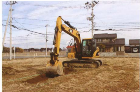
写真 186 重機掘削状況
