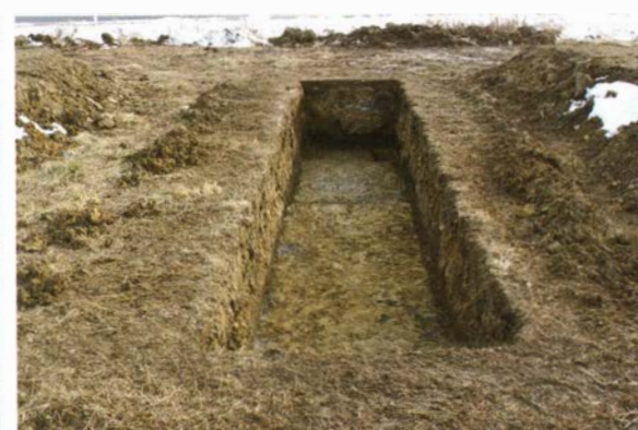
写真 48 13 T 調査状況
