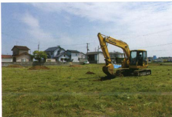
写真 175 重機掘削状況
