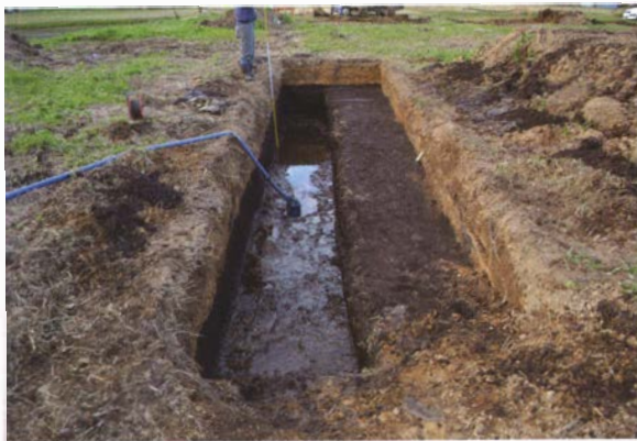
写真 143 11 T 調査状況
