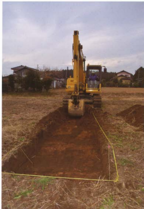
写真 159 重機掘削状況
