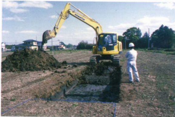
写真 71 重機掘削状況
