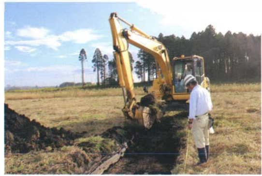
写真 28 重機掘削状況
