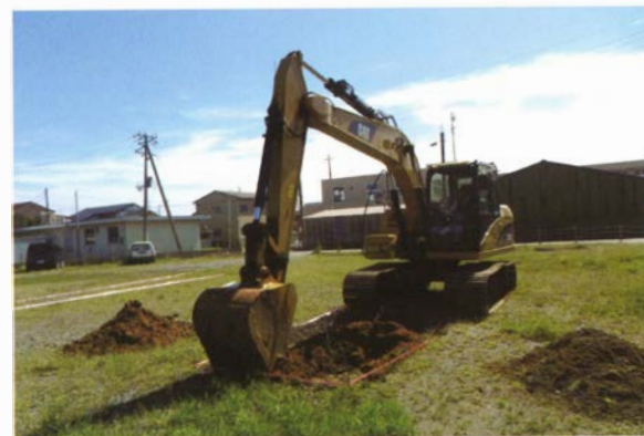
写真 212 重機掘削状況
