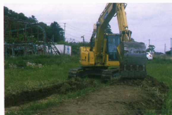
写真 55 重機掘削状況
