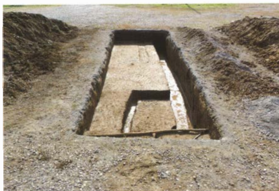
写真 209 4 T 調査状況
