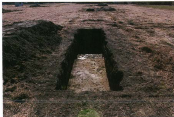
写真 120 6 T 調査状況
