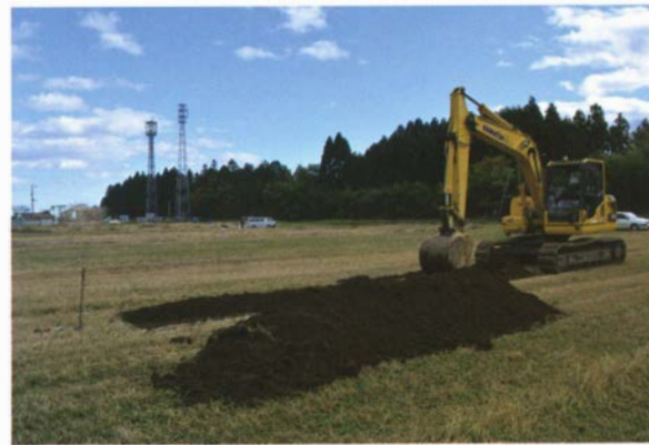
写真134 重機掘削状況
