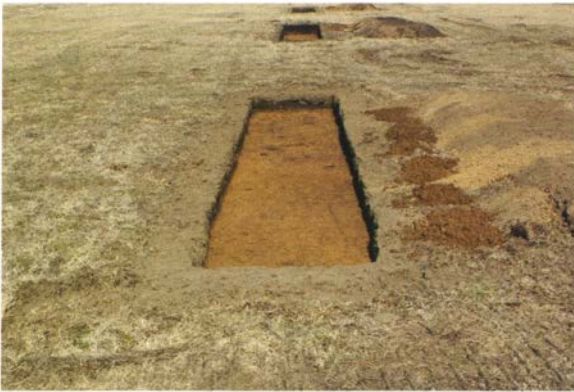
写真 90 2 T 調査状況
