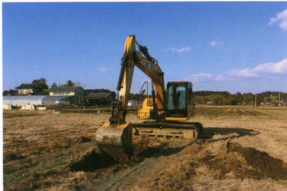
写真 114 重機掘削状況
