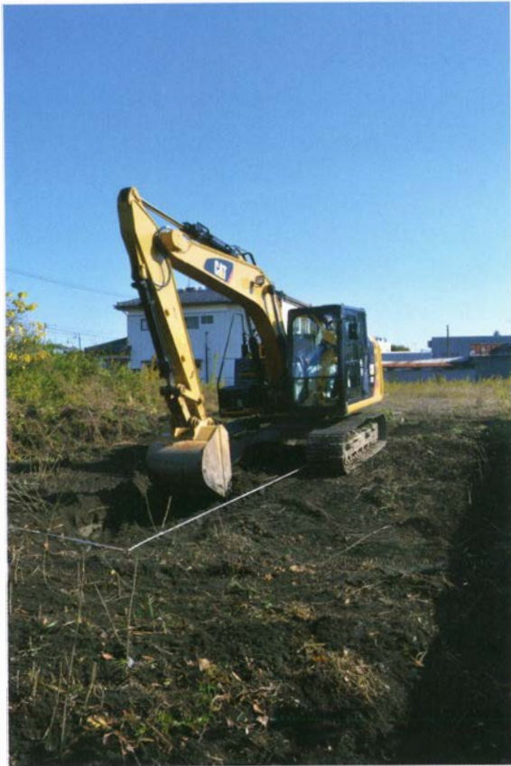
写真 246 重機掘削状況
