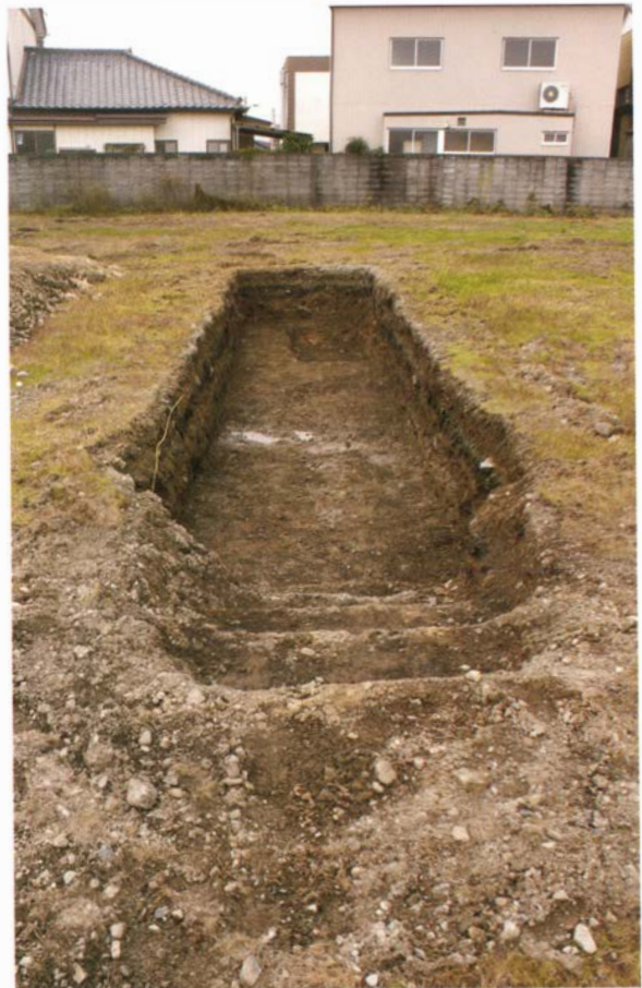
写真 239 7 T 調査状況
