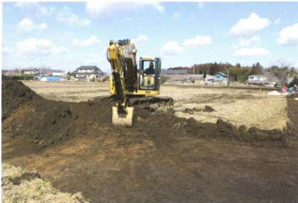
写真 153 重機掘削状況 (A区)
