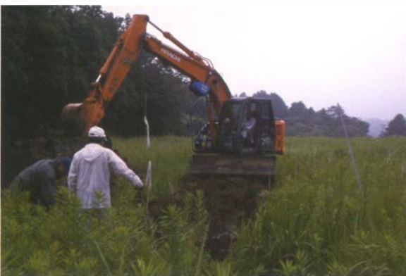
写真 99 重機掘削状況
