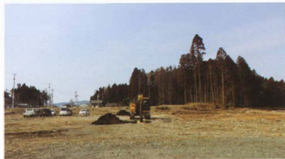
写真 256 重機掘削状況
