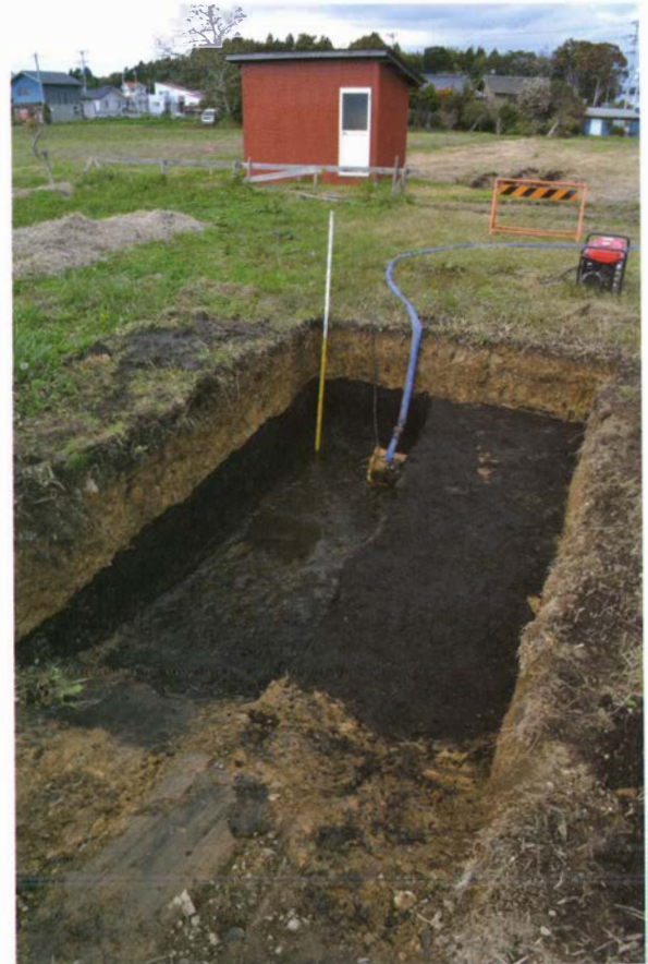
写真 140 8 T 調査状況
