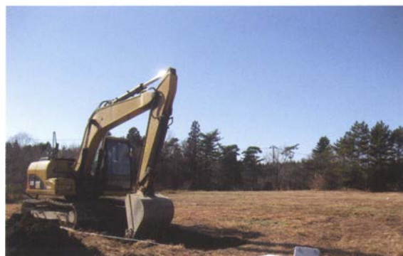
写真22 重機掘削状況
