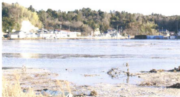
写真6 東日本大震災被害状況（6）
