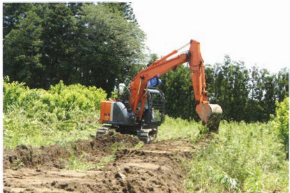
写真 78 重機掘削状況
