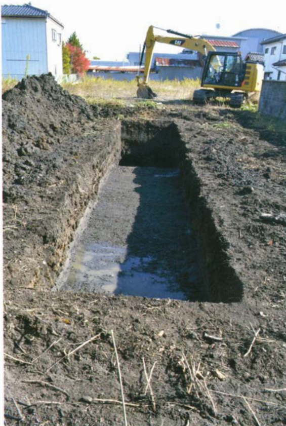
写真 248 2 T 調査状況
