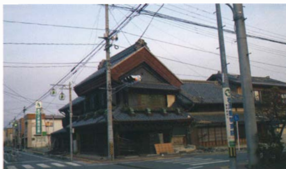
写真11 東日本大震災被害状況(11)
