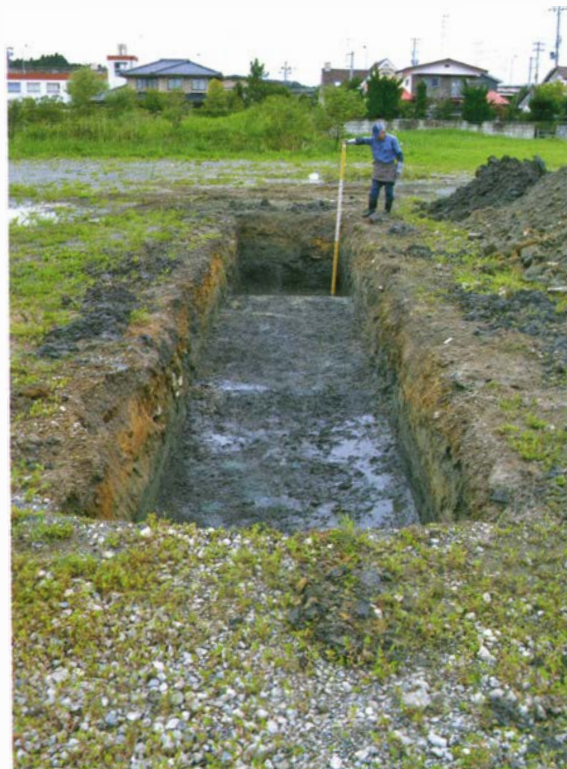
写真 244 3 T 調査状況
