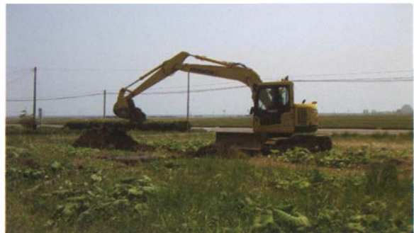
写真 291 重機掘削状況
