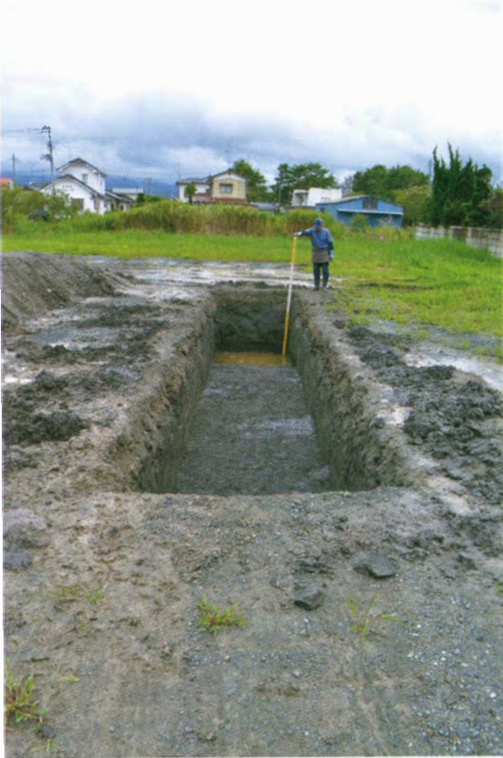
写真 242 1 T 調査状況
