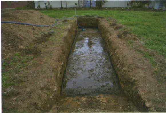
写真 135 1 T 調査状況
