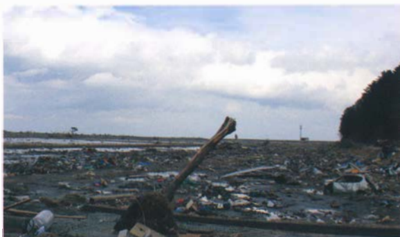
写真9 東日本大震災被害状況(9)
