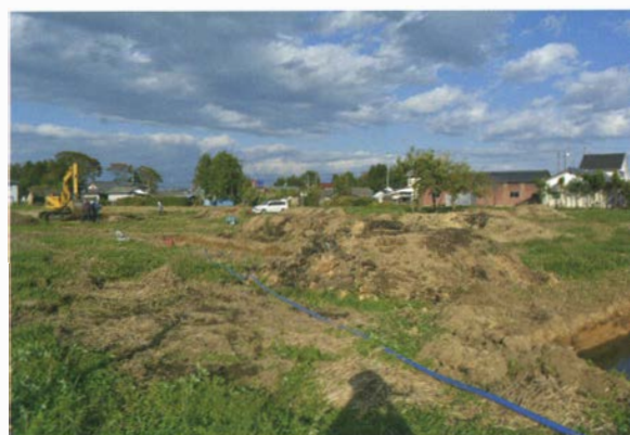
写真133 重機掘削状況
