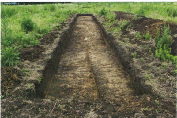
写真 77 35 T 調査状況
