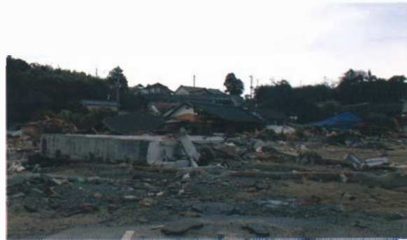
写真10 東日本大震災被害状況(10)
