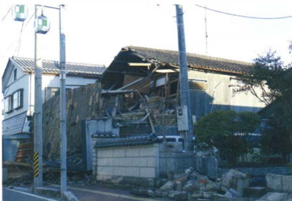
写真5 東日本大震災被害状況（5）
