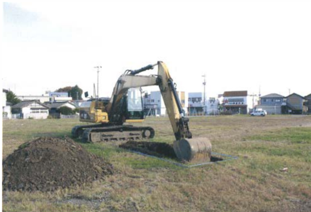
写真 25 重機掘削状況 (H24 大町地区)
