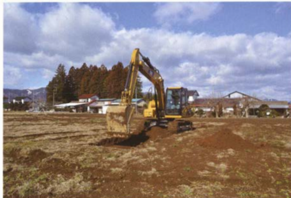
写真 194 重機掘削状況
