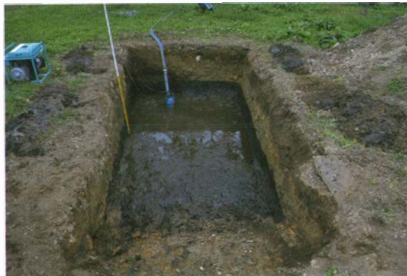
写真 137 3 T 調査状況
