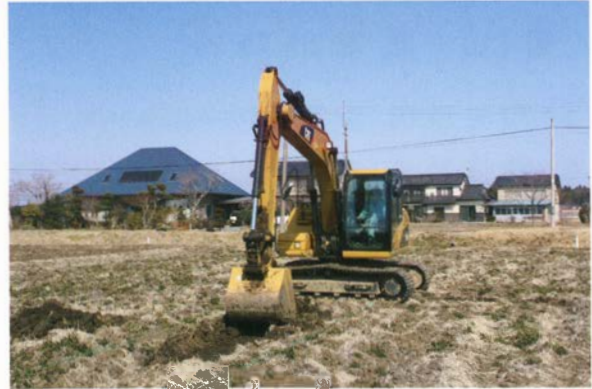
写真 58 重機掘削状況
