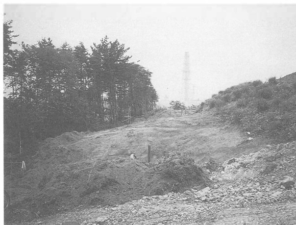
写真24 表土除去後(南から)
