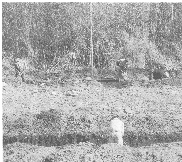
写真15 作業状況(北から)
