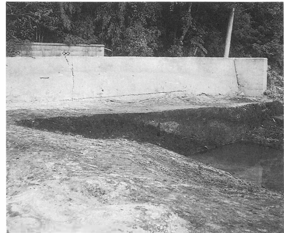
写真8 北斜面土層断面(南東から)
