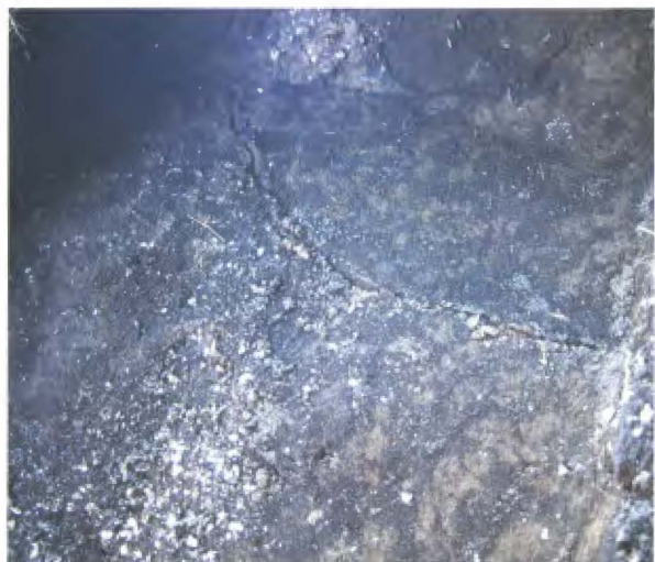
写真128 37T調査状況 (東から)
