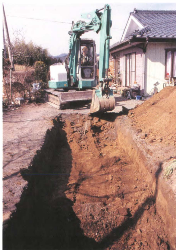
4 埋め戻し作業
