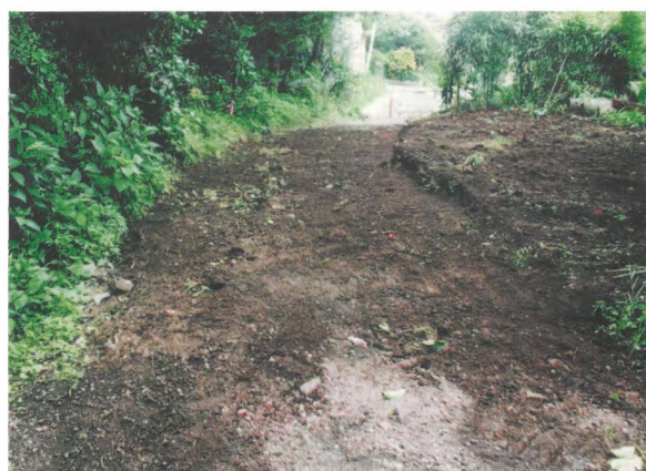
5 埋め戻し状況
