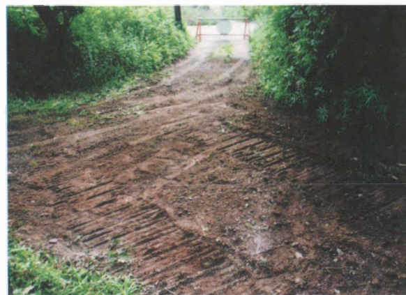
4 埋め戻し状況
