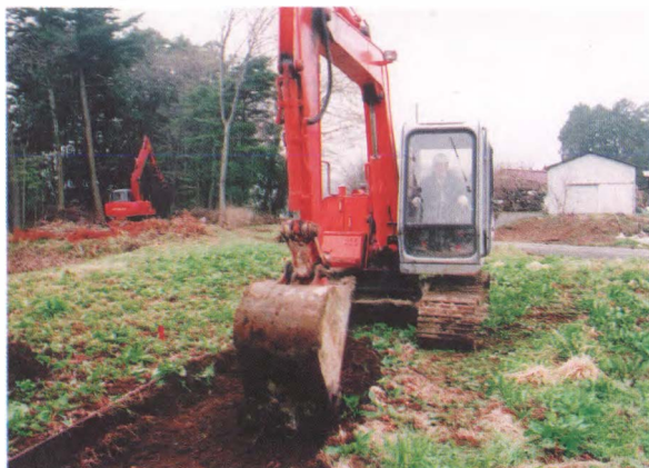
2 表土除去作業
