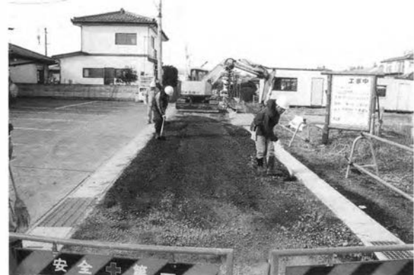
6 A地区埋め戻し作業
