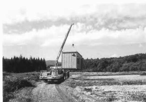
3 施設搬入状況
