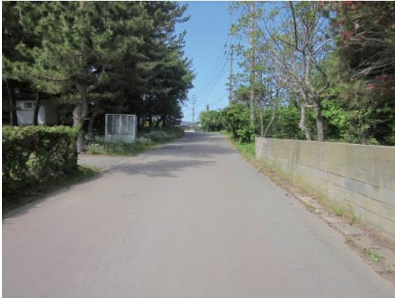
⑬ 市道亀ヶ岡館岡線
