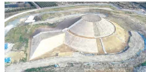
30 年度工事完成 南から
