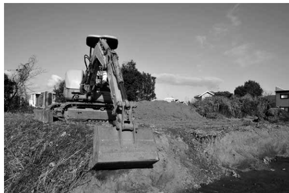
写真1 重機による表土掘削作業
