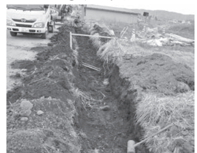
⑩掘削状況
