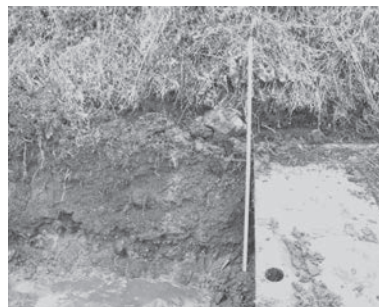
③掘削状況
