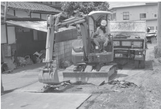
④中原遺跡6 掘削状況
