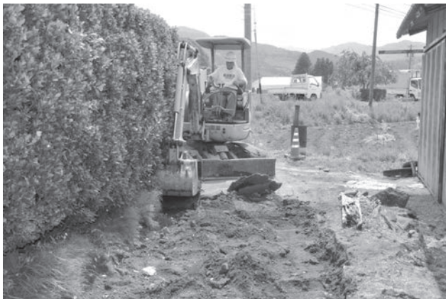
①筒畑遺跡群 9 掘削状況
