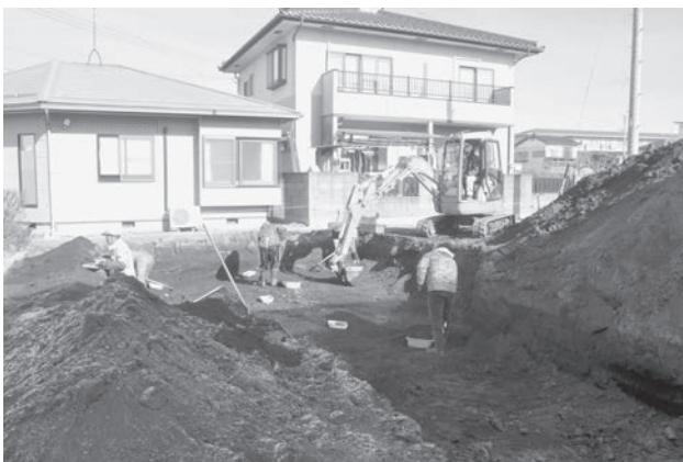
遺構調査状況
