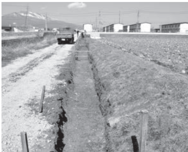
①掘削状況
