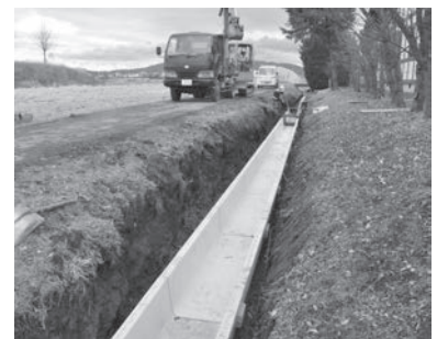
⑦掘削状況
