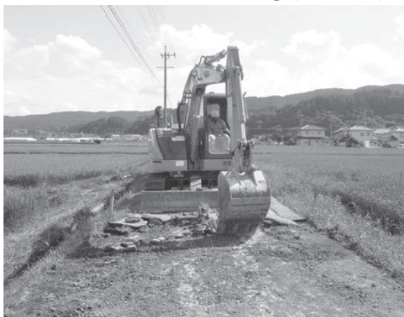
⑥中道遺跡群30 掘削状況
