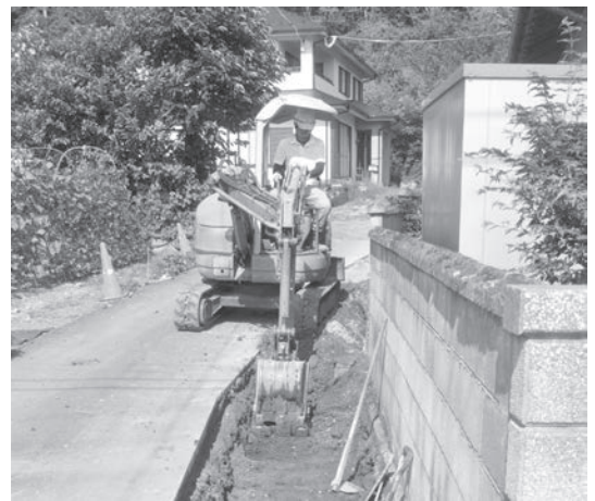
③スポイリ遺跡2 掘削状況
