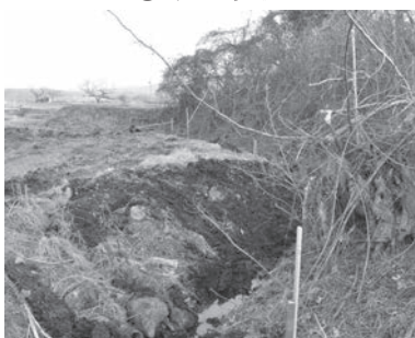
⑧掘削状況
