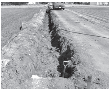
⑤掘削状況
