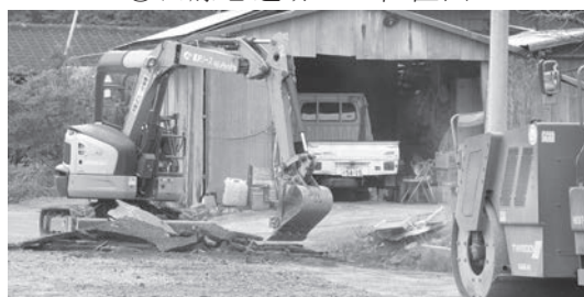
②横道上遺跡 1 掘削状況
