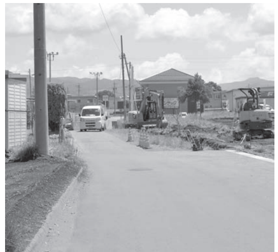
②寺畑遺跡群42 掘削状況
