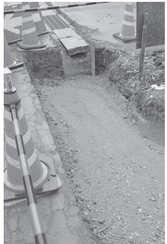
⑩城下遺跡14 施工状況
