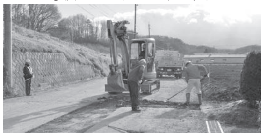
③西藤巻遺跡 1 掘削状況
