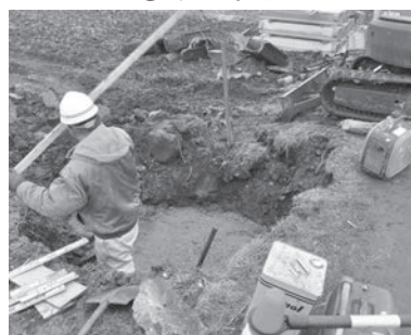
⑨掘削状況
