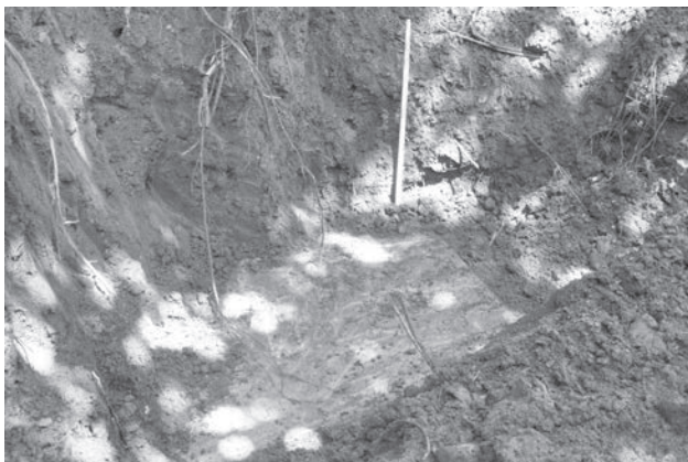
埋設物確認状況
