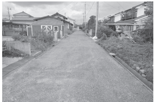
⑤熊の堂遺跡8 施工状況
