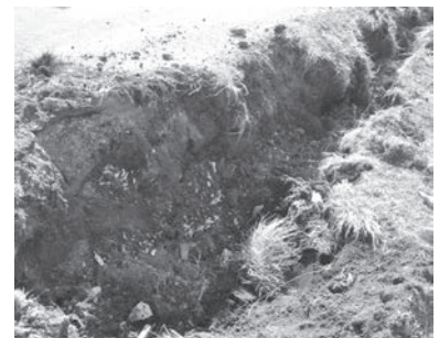
④掘削状況
