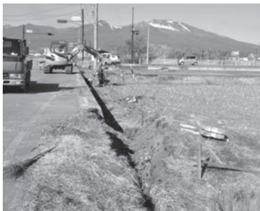
②掘削状況
