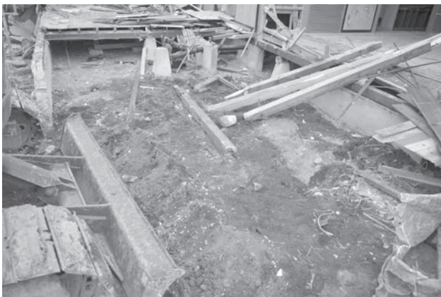
建物解体状況
