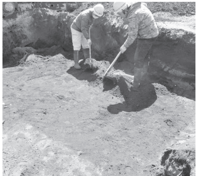
掘削・調査状況
