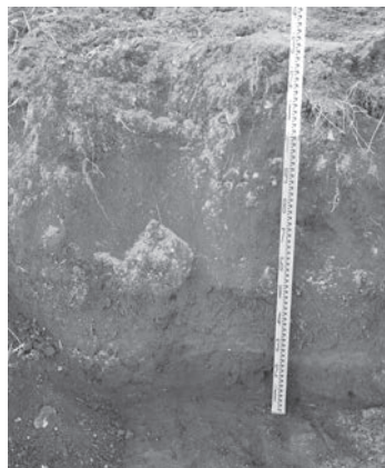
擁壁設置箇所堆積状況
