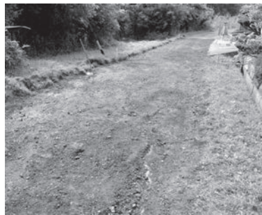
②掘削状況
