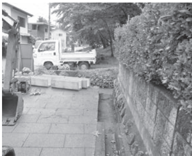
①掘削状況
