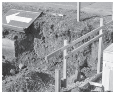
⑥掘削状況
