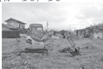
①掘削状況
