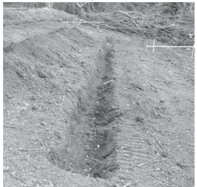
丸山上遺跡 1 掘削状況
