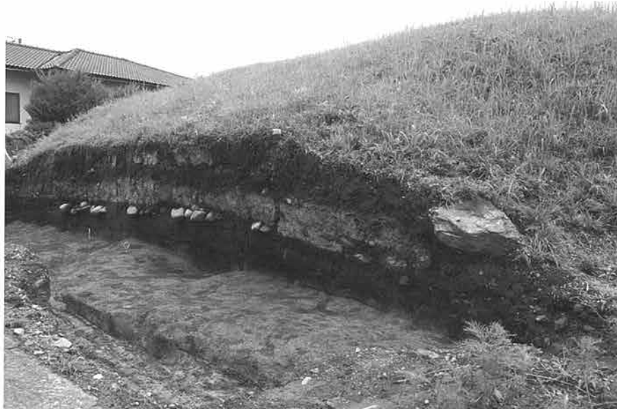
1 南北土層断面 (南西から)
