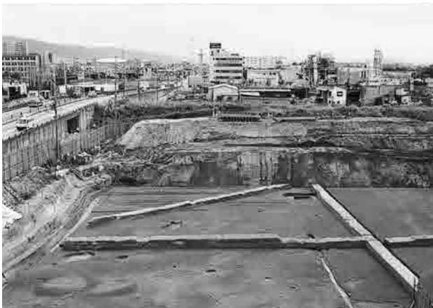
2 3区第5面東部（北から）
