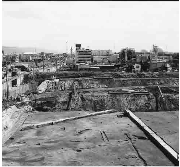
2 3区第6面東部（北から）
