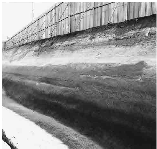
6 1区南壁断面(北西から)
