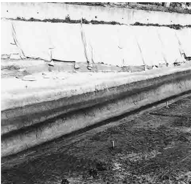
5 3区路線中央セクション断面(南西から)
