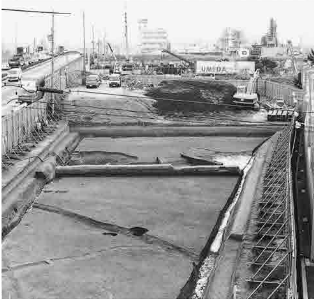
1 5区第5面全景（北から）
