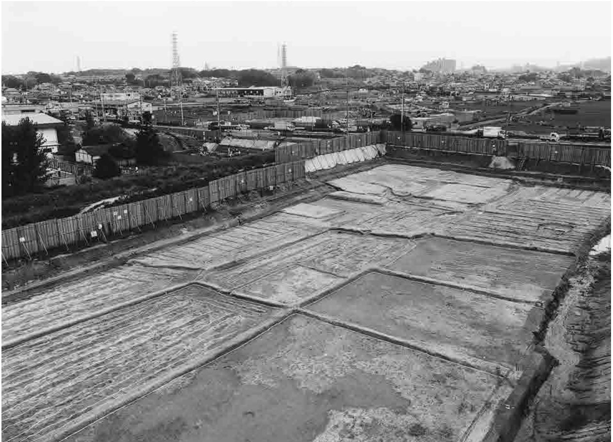
1 3区第2面全景（西南西から）
