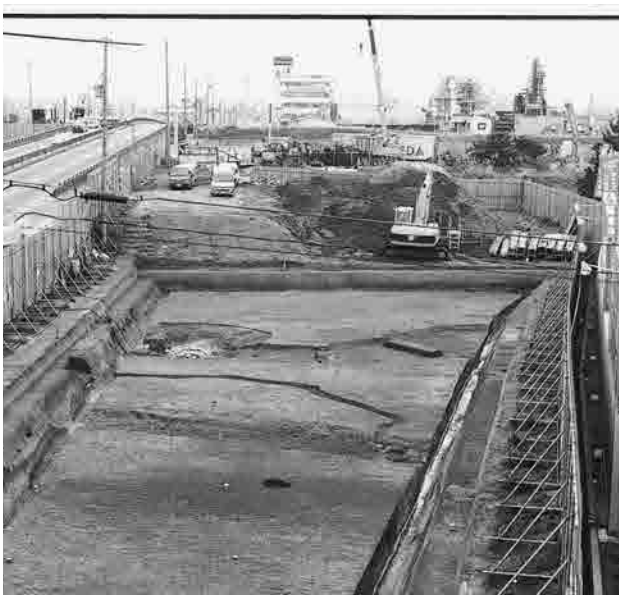
5 5区第6面全景（北から）
