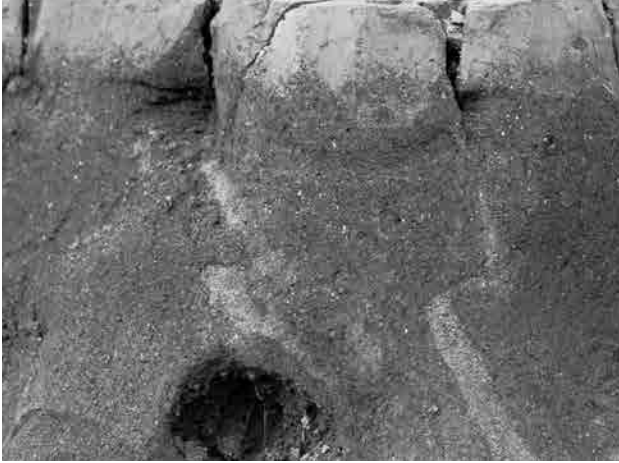
1. 噴砂 断面 (南から)
