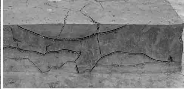
1. 080922溝 断面 (南西から)
