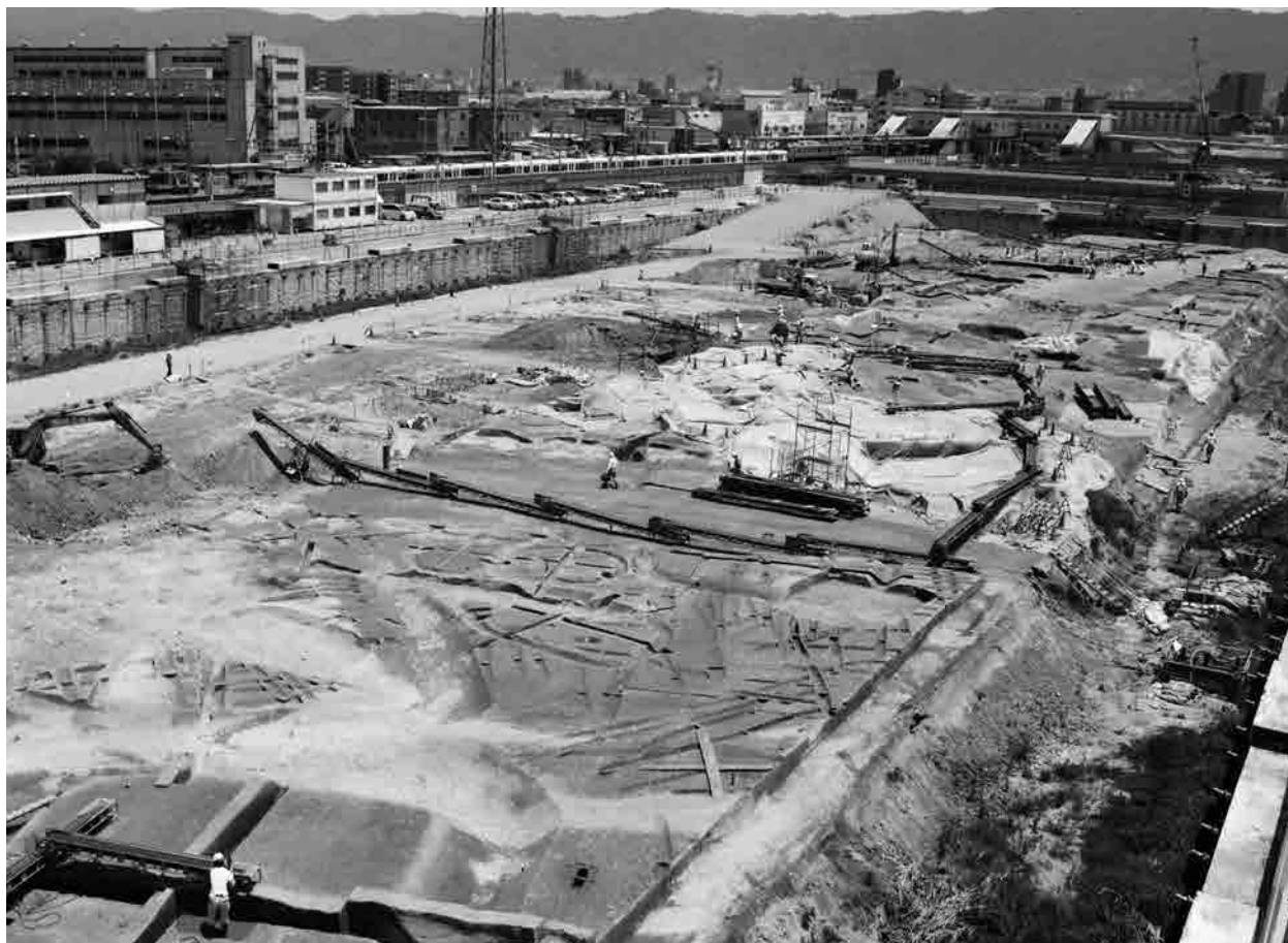
2. 中部南半 (西から)
