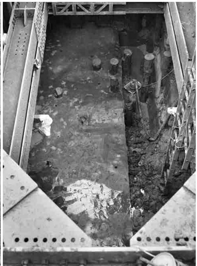
4. 04-1 調査区（北西から）
