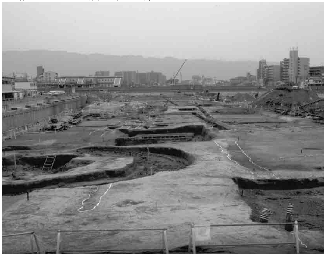
1. 0004軌道敷 (西から)
