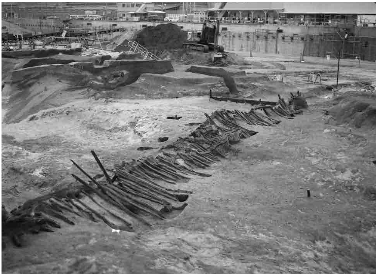
2. 上流側 全景（南東から）
