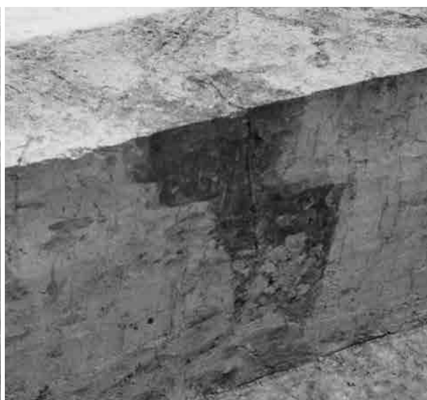
5. 080097ピット 断面 (南から)
