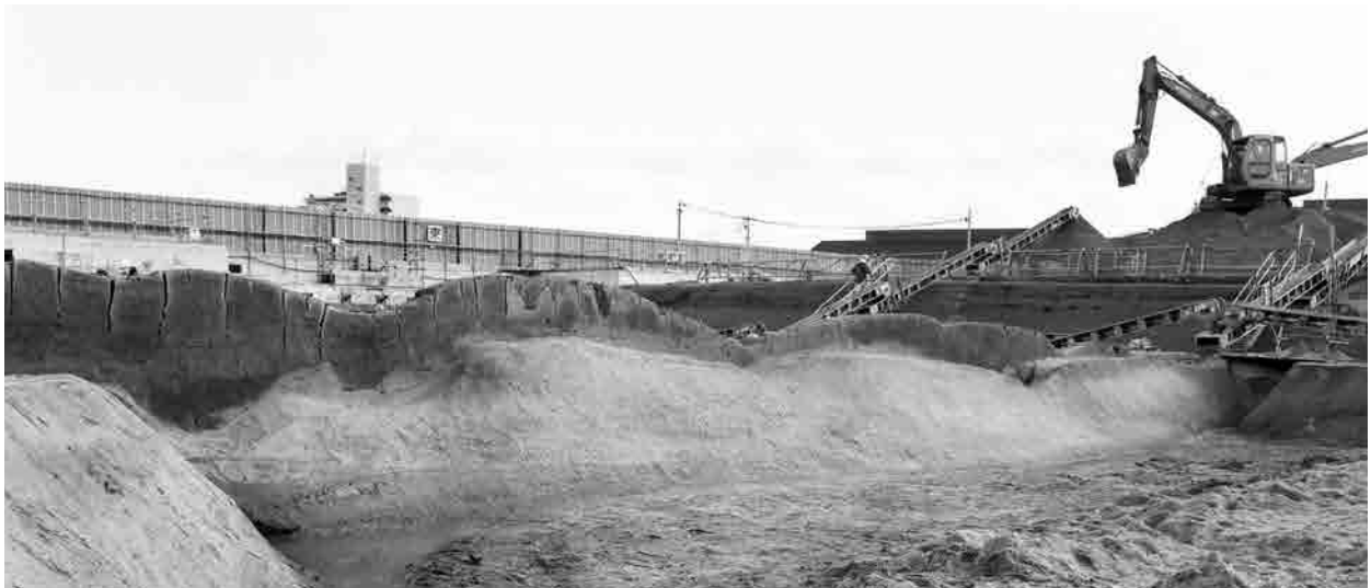
7. 09003 流路 断面 (北西から)
