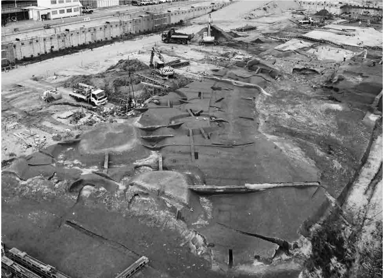
1. 中部南半 (西から)
