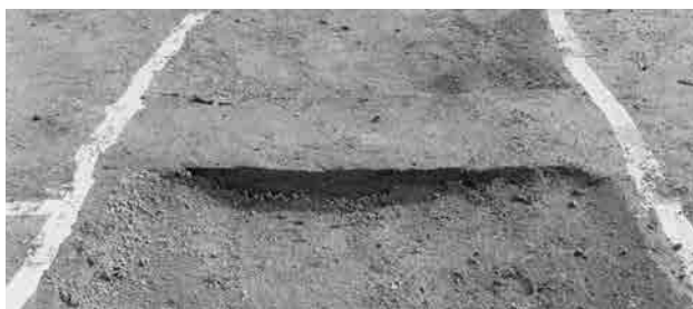
7. 080965溝 断面 (西から)
