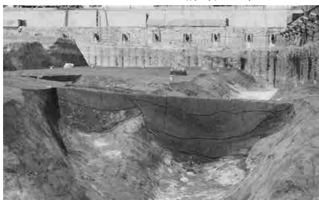
3. 080002～080004溝 断面① (南から)
