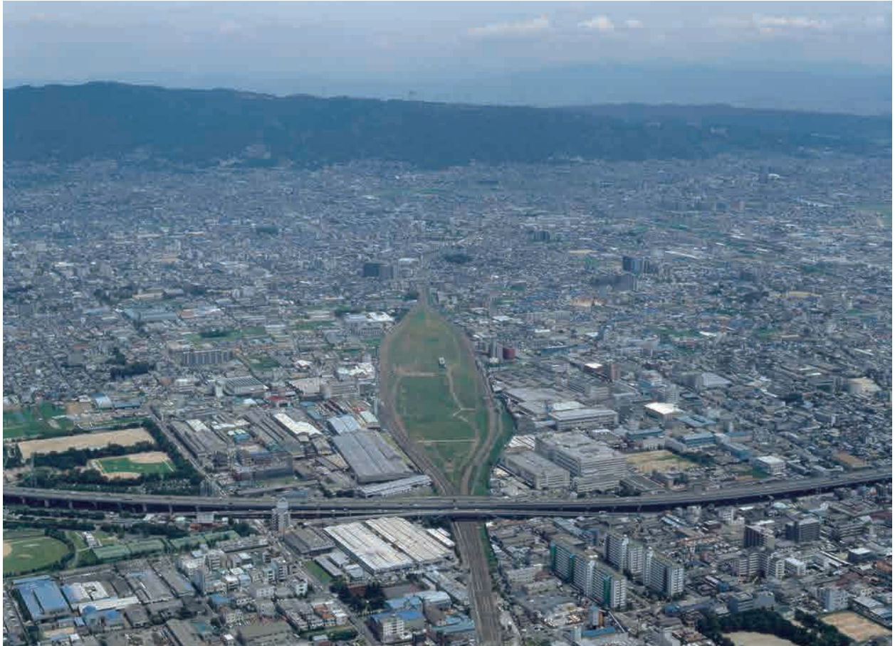
1. 竜華操車場調査前風景 (1996年 撮影) 北西から
