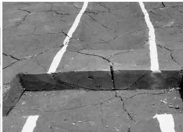
2. 080908溝 断面⑤ (北から)
