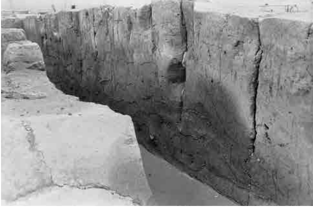
29号墳：1. 南側墳丘 断面（南西から）
