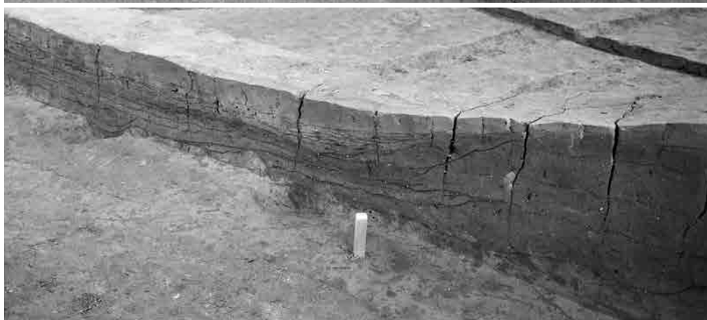
5. 080893溝、 07055 高まり 断面 (西から)
