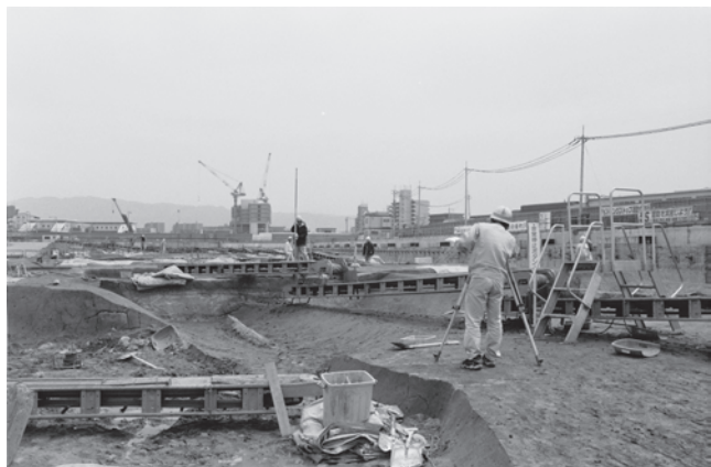
写真6 測量杭 打設風景
