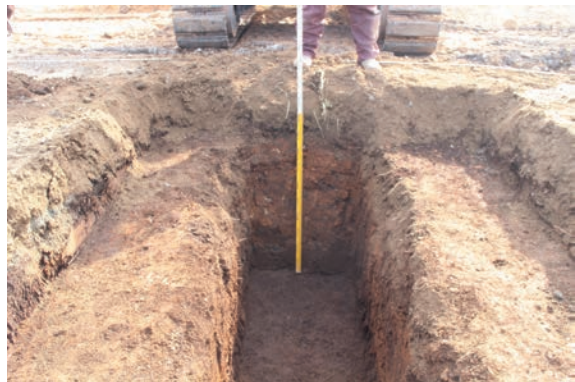
写真136 1 T 掘削状況
