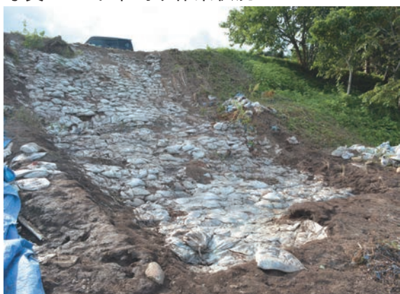
写真 14 ブルーシート撤去状況
