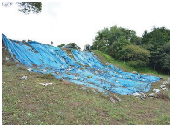
写真 13 下草刈り作業後状況
