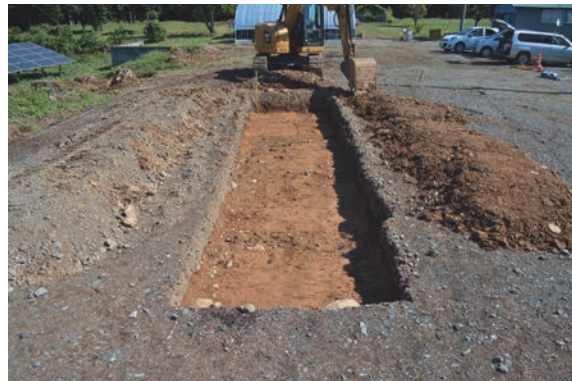
写真95 1 T調査状況
