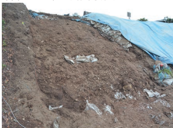
写真 15 土嚢撤去状況
