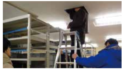
写真 275: 全熱交換器換気扇の設置状況確認 (令和2年1月27日)
