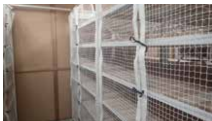
写真 207：落下防止ネットの設置作業 (平成 30 年 11 月 7 日)
