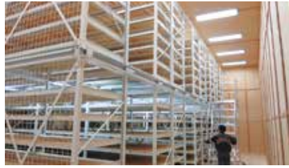
写真8：KICKの1階収蔵庫に設置の高層収蔵棚（平成27年3月25日）
