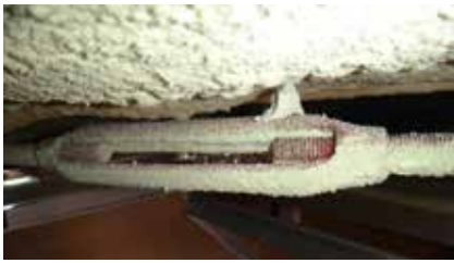
写真 273: D棟の点検口内部 (令和2年1月27日)
