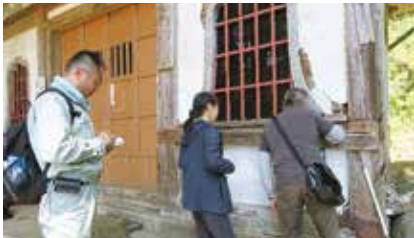
写真 73：熊本地震にかかる文化財救援体制構築のための調査(平成 28 年 5 月 14 日)
