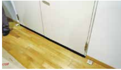
写真 26：KICK 収蔵庫内の前室扉下部に取り付けた害虫侵入防止用ブラシ (平成 28 年 1 月 15 日)
