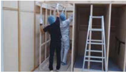
写真 25：KICK の 2 階収蔵庫屏風棚の改修 (平成 27 年 9 月 9 日)
