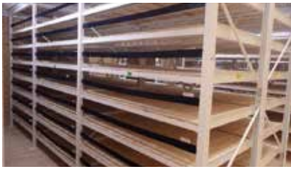
写真 271: 落下防止ベルト設置 (令和元年 12月 20日)
