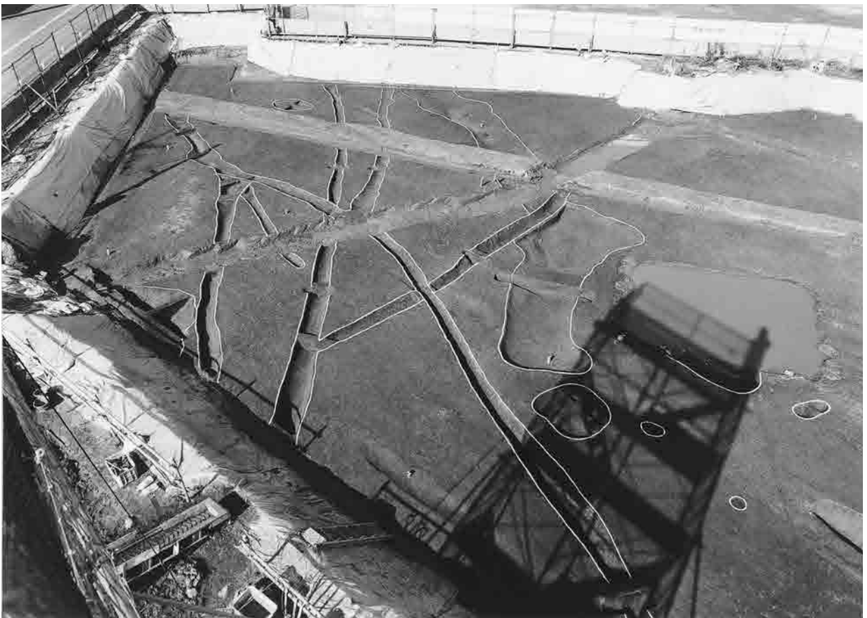
2. 8区 200・395・563～565・569溝ほか（南東から）
