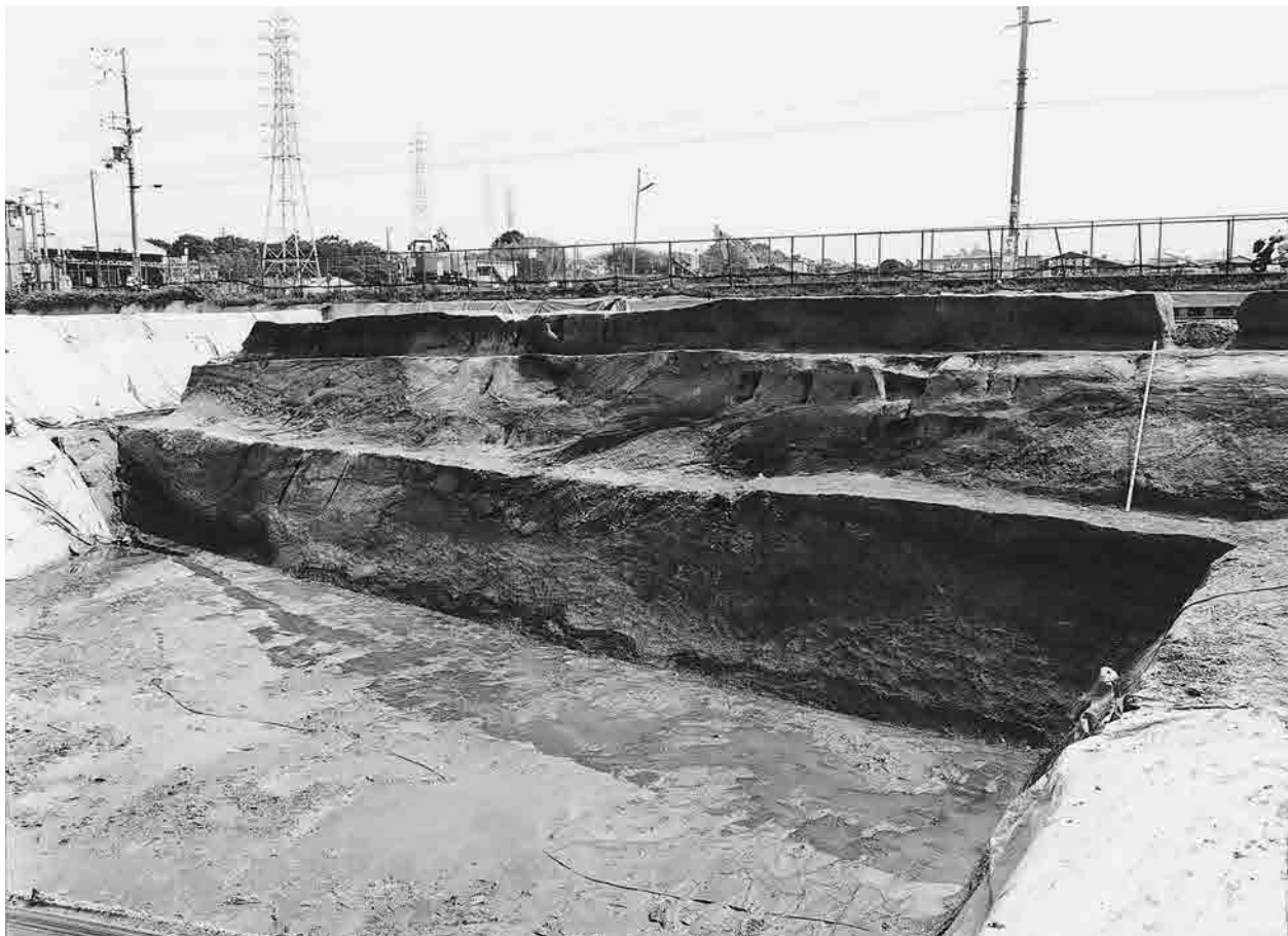
1. 5区 476流路断面（南西から）
