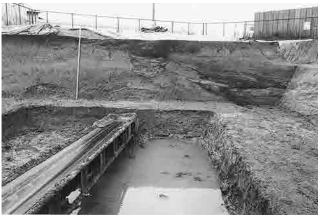
2. 4区 337流路断面（東から）
