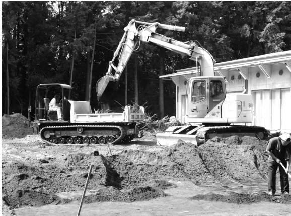
2. 表土除去（東から）
