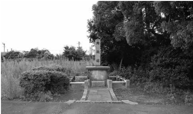
殉職碑（南東から）
