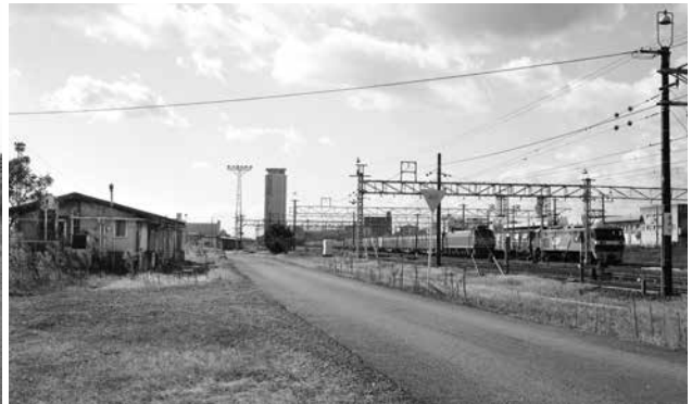
待機中の列車（右）と休憩所（左）（北東から）
