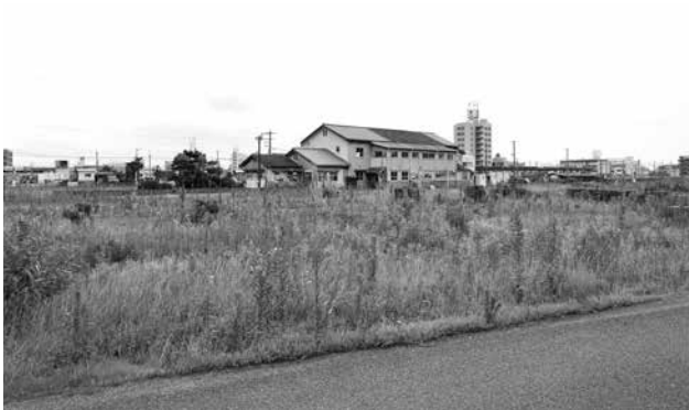
吹田操車場駅本屋（北から）
