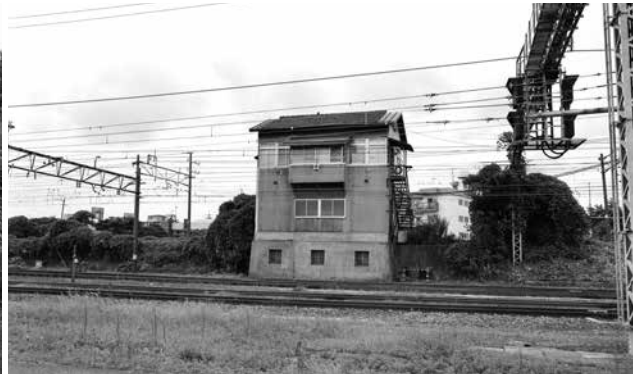
第6信号扱所（南東から）
