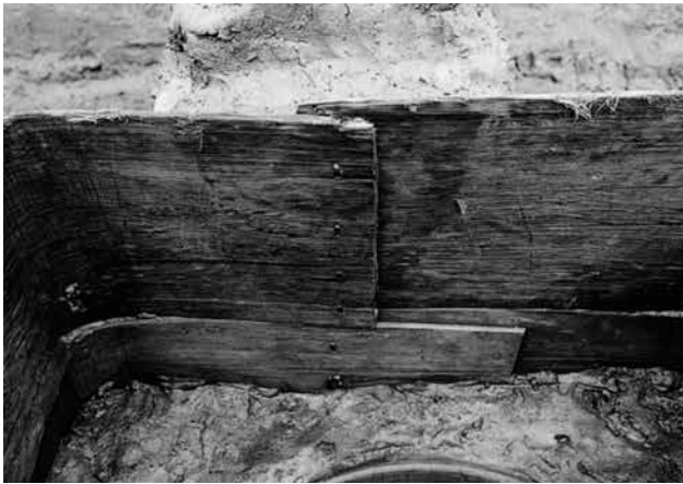
5 折櫃合わせ目内面（南西から）
