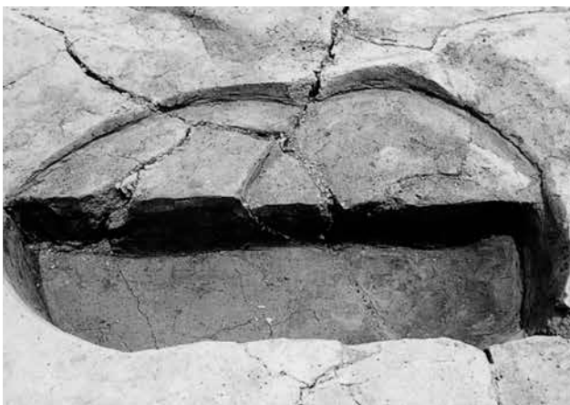
7 建物11 609柱穴断面 (西から)
