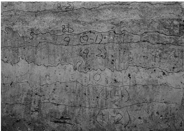
5 6区 道路中央断面北壁（北から）
