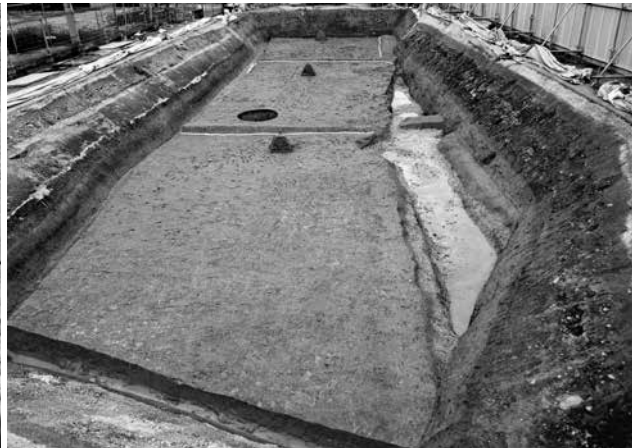
4. 第2面 (12トレンチ 西から)
