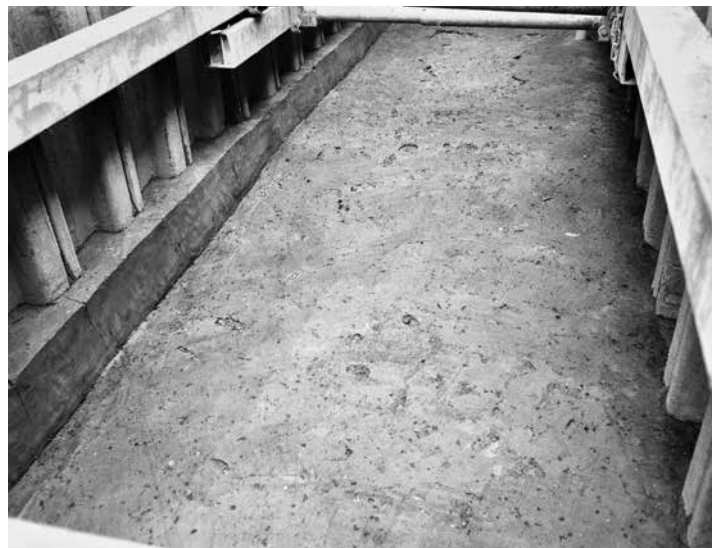
3. 08-1-3区 南端全景 (北西から)
