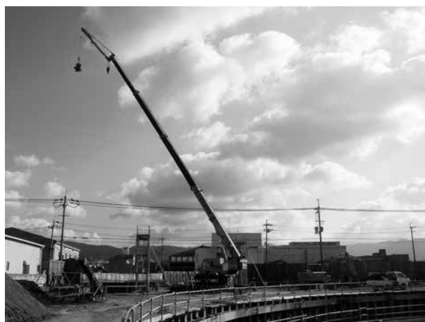
写真1 ラフタークレーンによる航空測量
