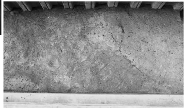
4. 08-1-3区 4溝内噴砂検出状況 (北東から)
