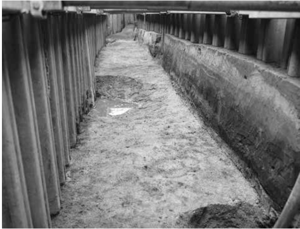
1. 08-1-3区 8流路(北端)検出状況 (南東から)
