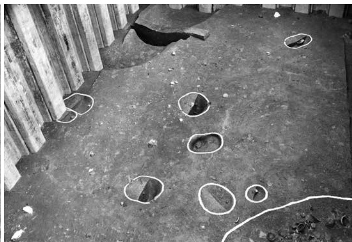
4. 08-1-2区 遺構掘削状況（西から）
