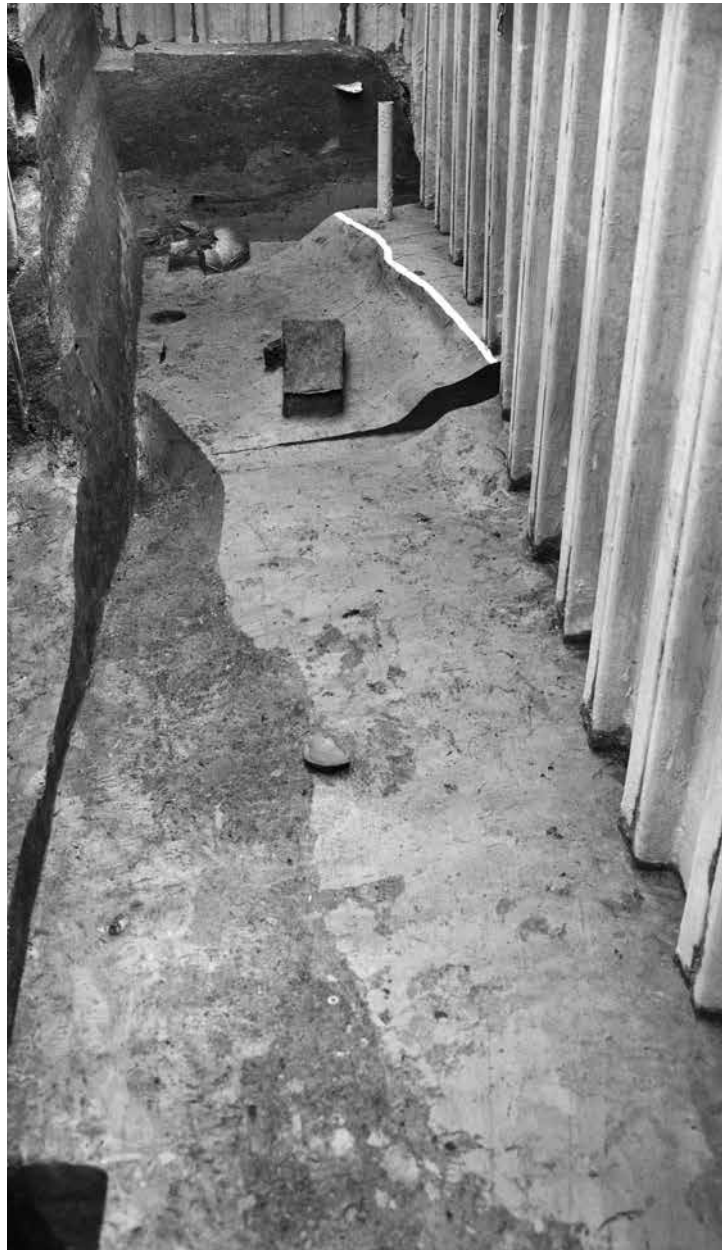
2. 08-1-3区 12溝近接（西から）
