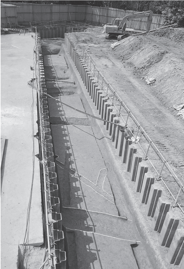
1 2区第6面全景 (北から)
