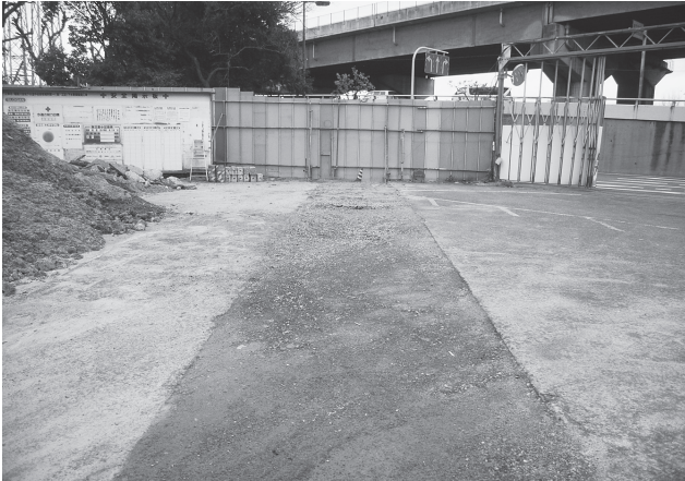
1 調査前風景 (北から)
