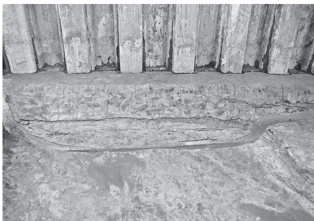
1 056 溝断面 (東から)
