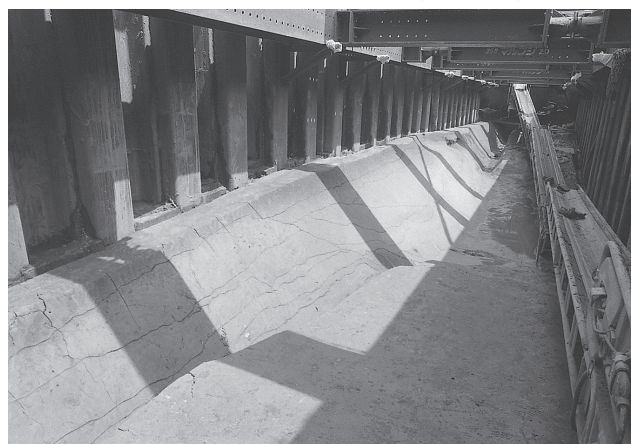
6 2区第14層の自然河道 (南東から)
