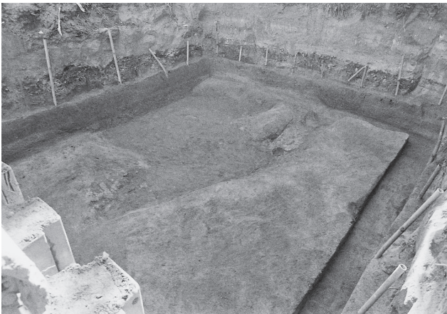
3 4区第2面全景 (北から)
