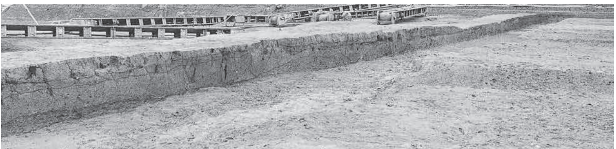
3. 4区 X=-158,150ライン断面 (南東から)
