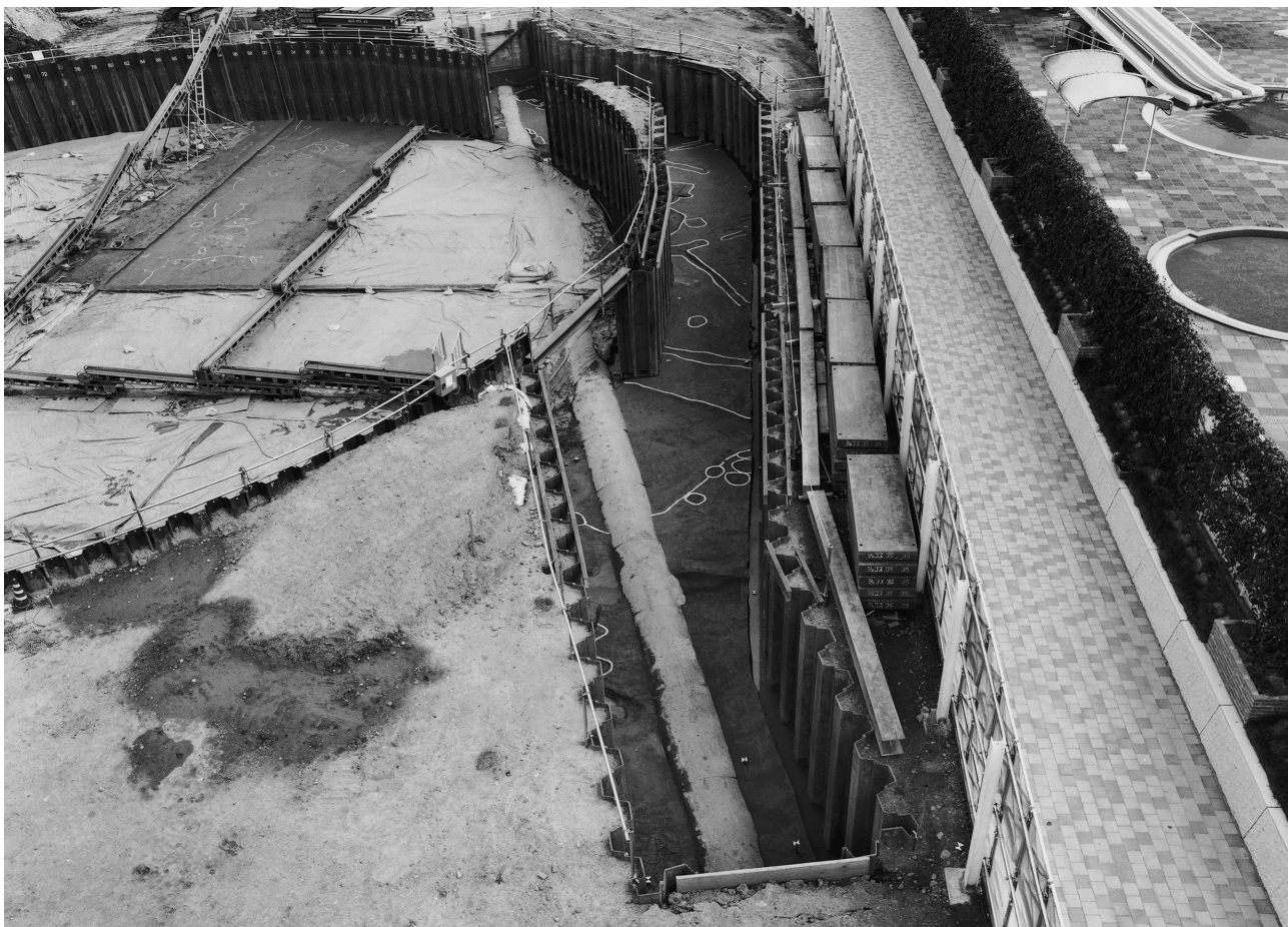
2. 2区 第4面 西半全景（西から）
