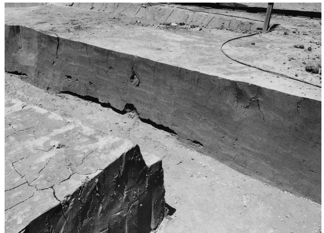
5. 1区 東西断面6層以下 (南東から)
