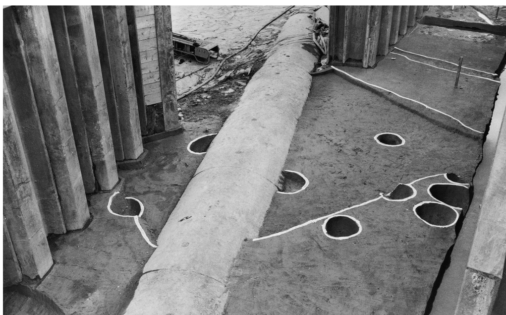
3. 2区 第4面 竪穴建物3 完掘状況 (南西から)
