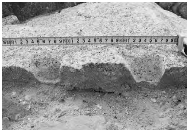
6. 68 石組溝間知石 石材 37 矢穴痕近接 (南東から)
