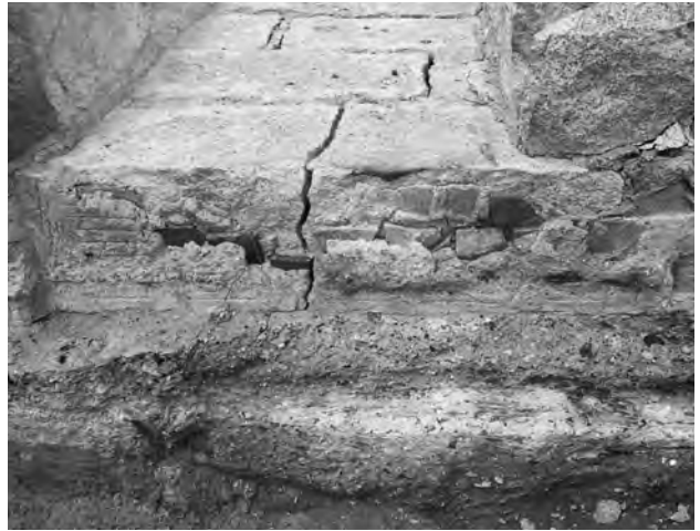
4. 26区画 北辺内面切石表面漆喰・瓦(南から)
