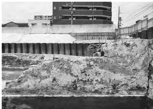
2. 2区画 西辺間仕切り壁表面の漆喰 (東から)
