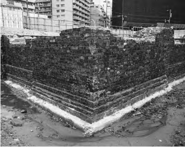
1. 外周壁南西隅外面 (南西から)
