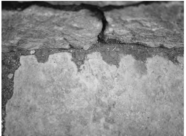
8. 石材 55 矢穴痕 (24 区画 68 石組溝底石) (北から)
