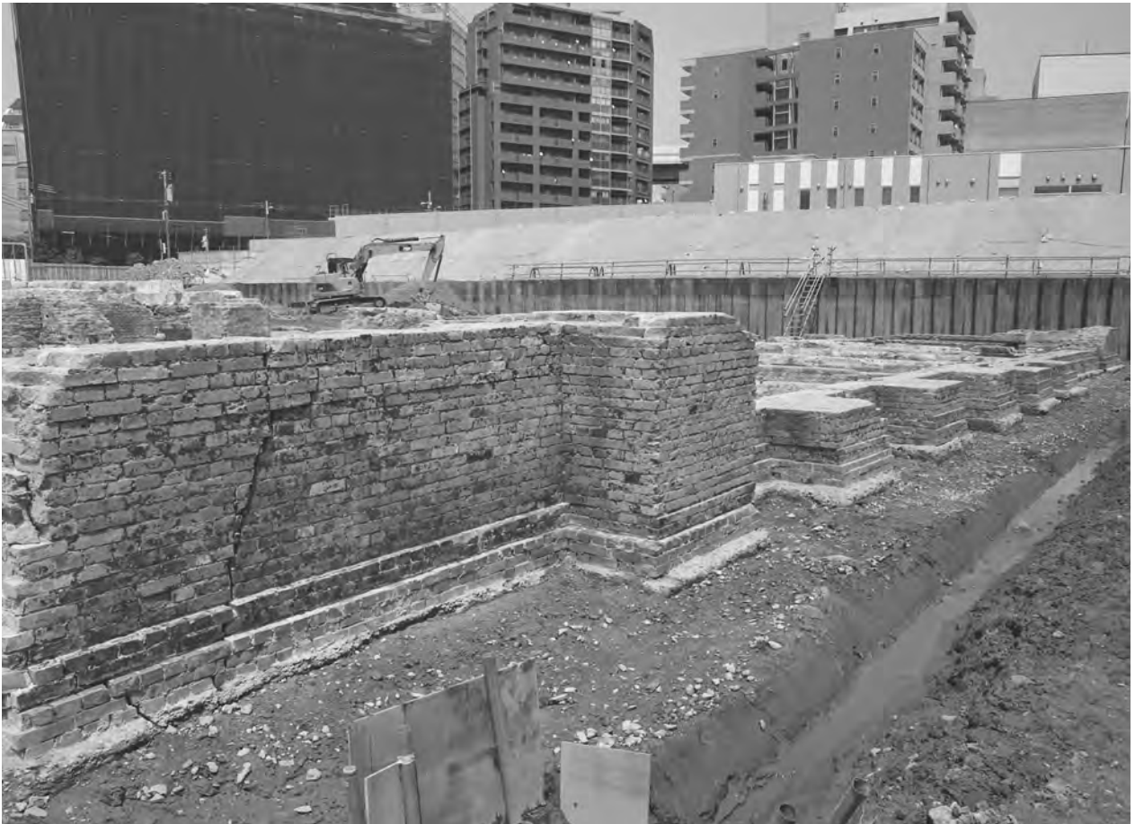
2. 外周壁南辺外面 (南西から)
