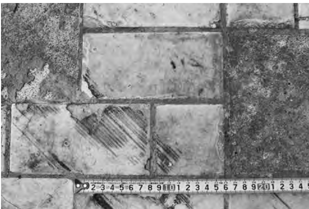
7. 10区画 床面タイル近接 (西から)
