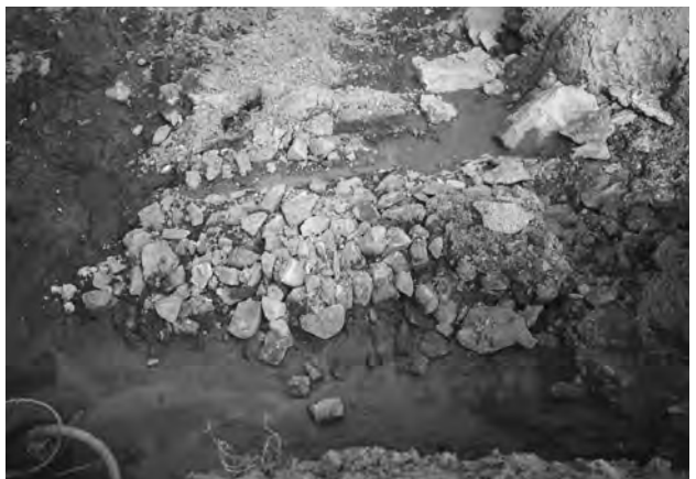
8. 北西隅 コンクリート基礎下の栗石 (西から)
