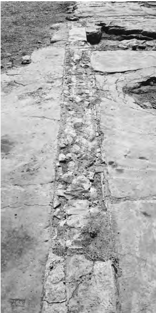
3. 8区画・13通路間 間仕切り壁基部 (西から)
