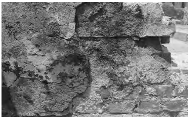
4. 8区画 北西隅間仕切り壁表面の漆喰 (東から)
