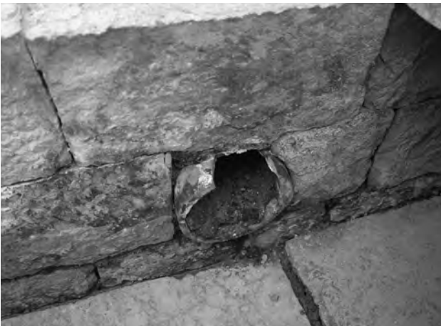
5. 68 石組溝に接続する 74 土管 (南西から)
