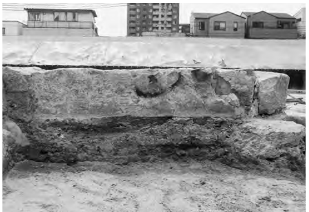
7. 23 区画 西辺基礎 (東から)
