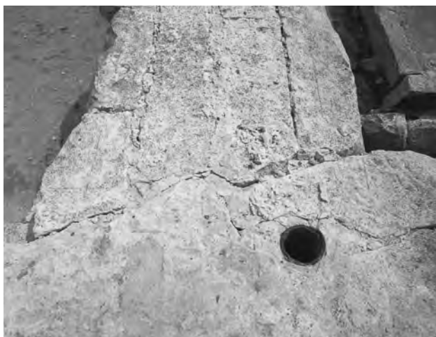
6. 27区画・31通路間 切石上墨打ち痕跡 (北から)
