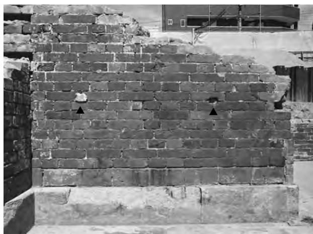
6. 12区画 西辺内面不明痕跡 (▲印) (東から)
