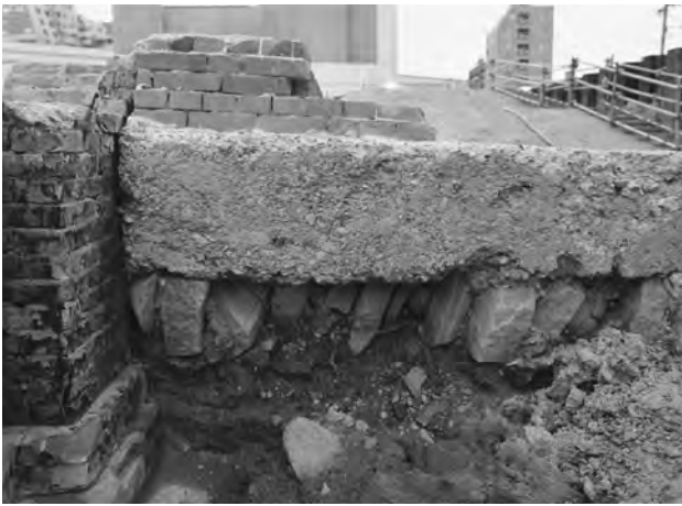
3. 52区画 コンクリート基礎断面 (北から)
