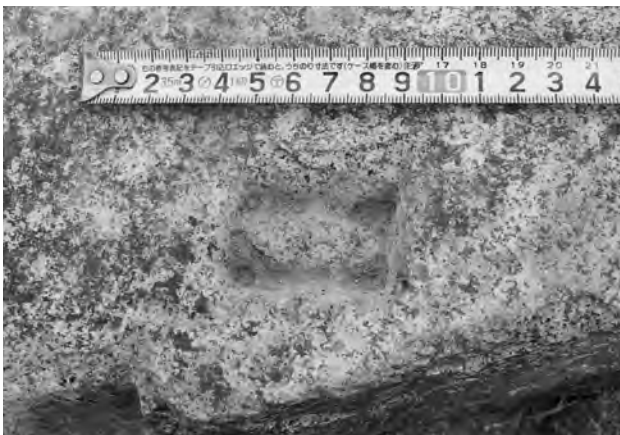
7. 68 石組溝間知石 石材 47 矢穴痕近接 (東から)
