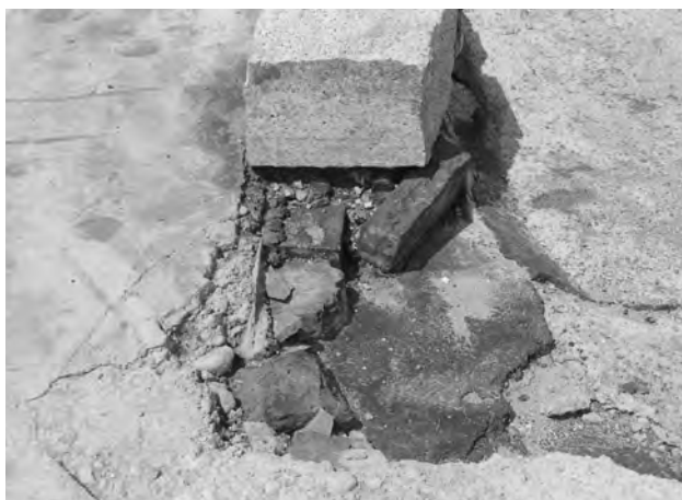
4. 50・51 区画間 間仕切り壁基部 (南から)
