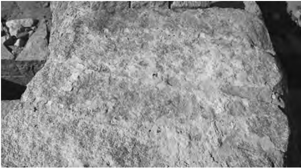
5. 石材 11 ~ 13 矢穴痕 (24 区画東側平面) (南から)
