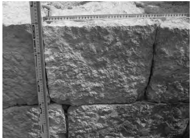
8. 68 石組溝 間知石側面 (南から)
