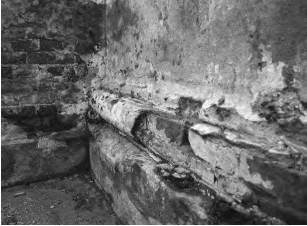
1. 9区画 南西柱東辺漆喰による成形 (北東から)
