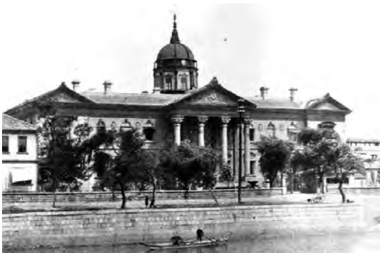
写真1 大阪府庁（増改築前）（明治後半）
