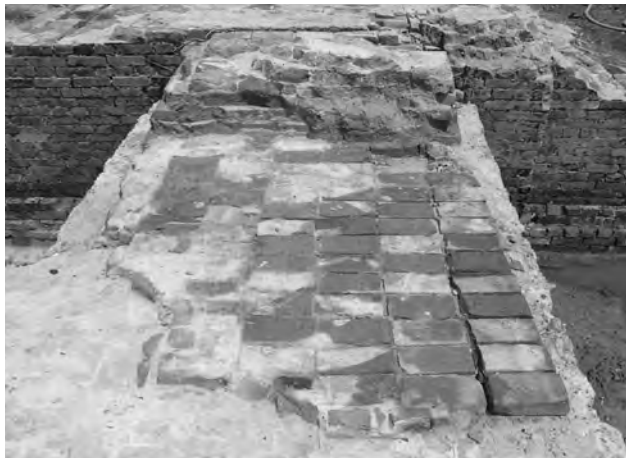
4. 52区画 コンクリート基礎上の煉瓦 (西から)
