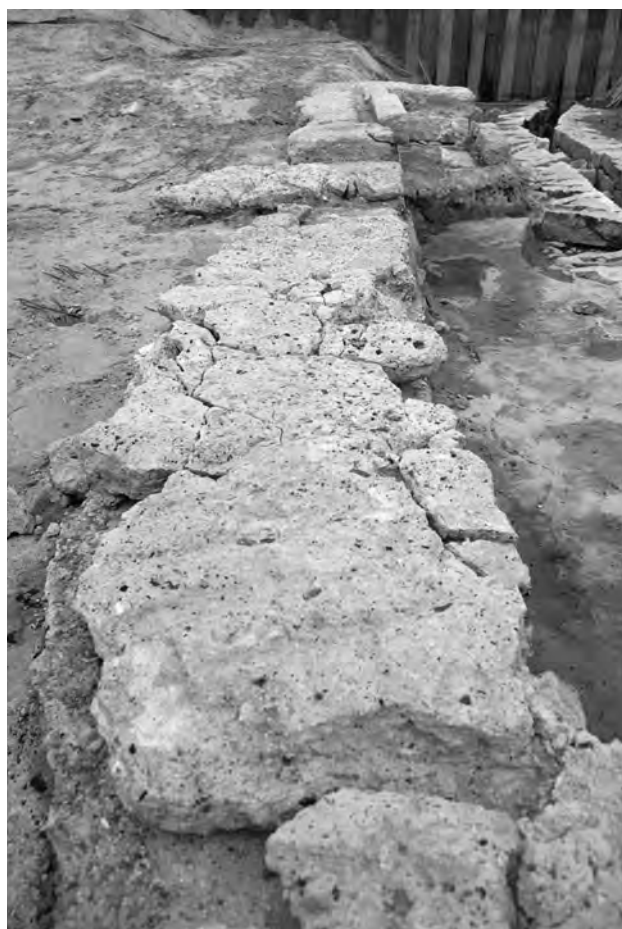
5. 21・25区画間 コンクリート基礎 (西から)
