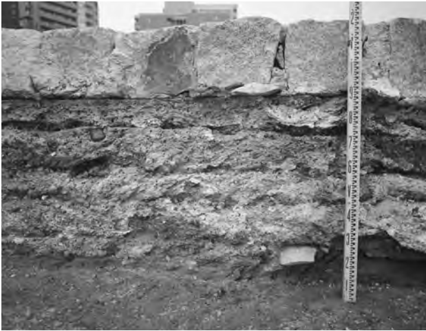
3. 26区画 西辺外面基礎(西から)
