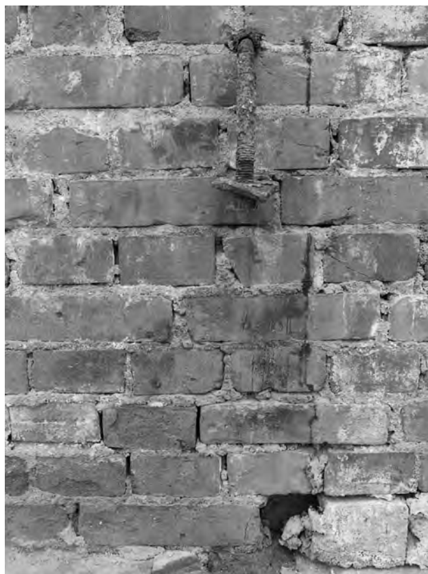
6. 43・44区画間 間仕切り壁南延長の外周壁南辺内面 (北から)
