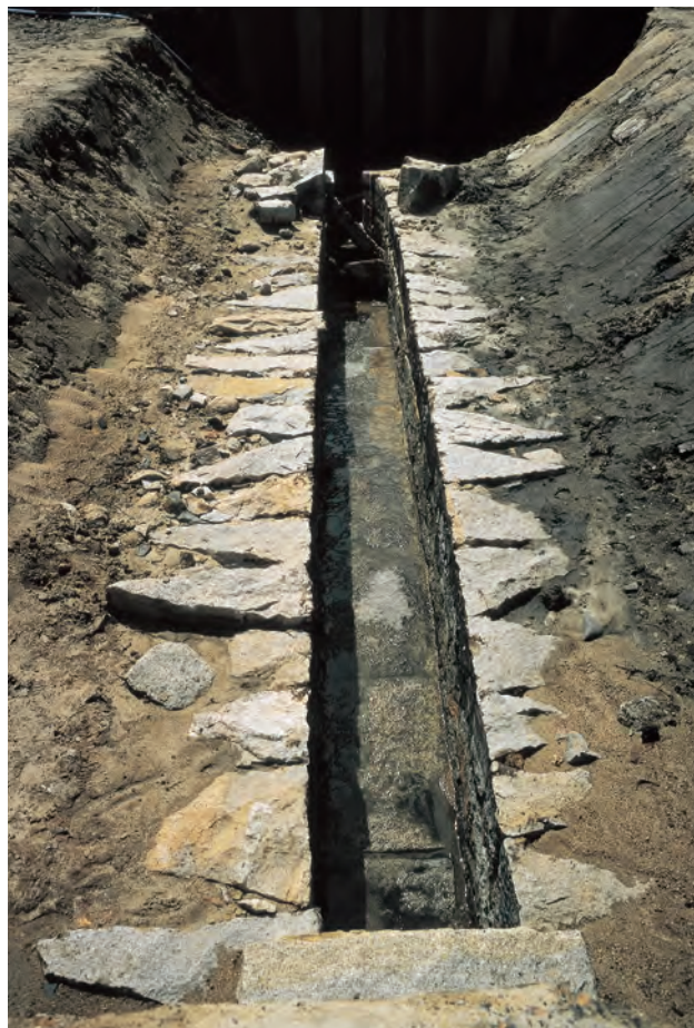
3. 中央棟 68 石組溝西端 (東から)
