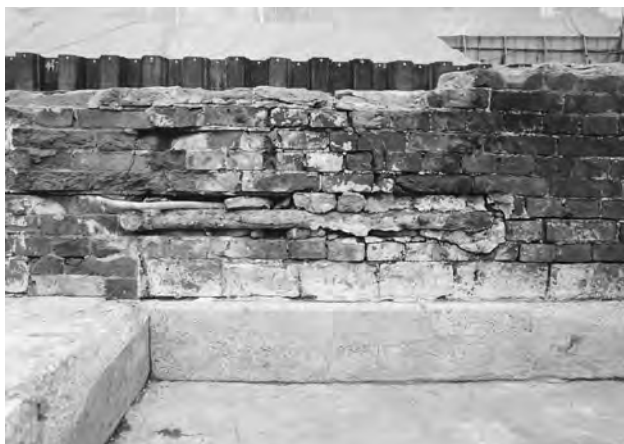
1. 1区画 外周壁西辺内面の配管 (東から)
