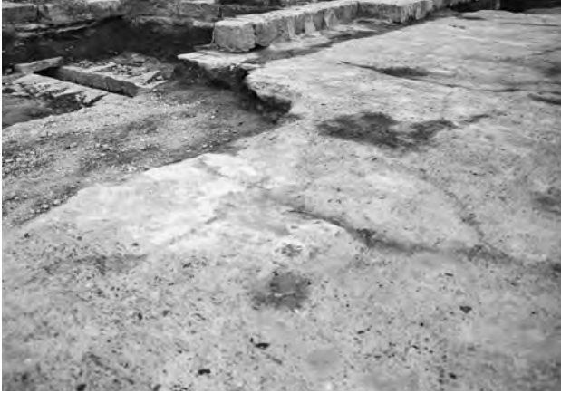
1. 22 玄関 基礎上北側モルタル痕跡 (北西から)
