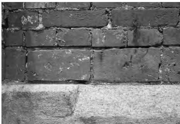
1. 12区画 西辺内面最下段煉瓦刻印 (左:大阪窯業、右:岸和田煉瓦)(東から)
