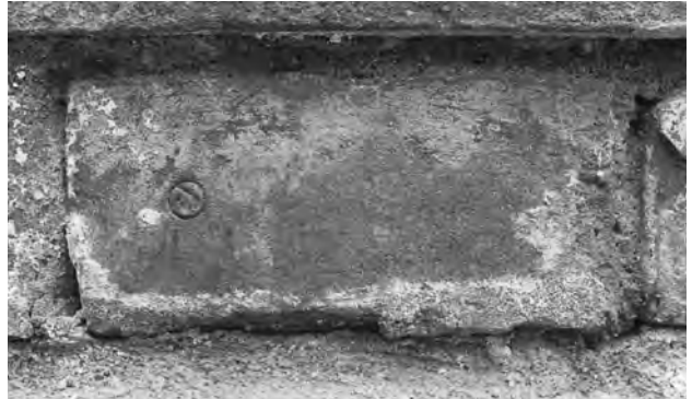
6. 9区画 外周壁南辺内面煉瓦刻印 (北から)
