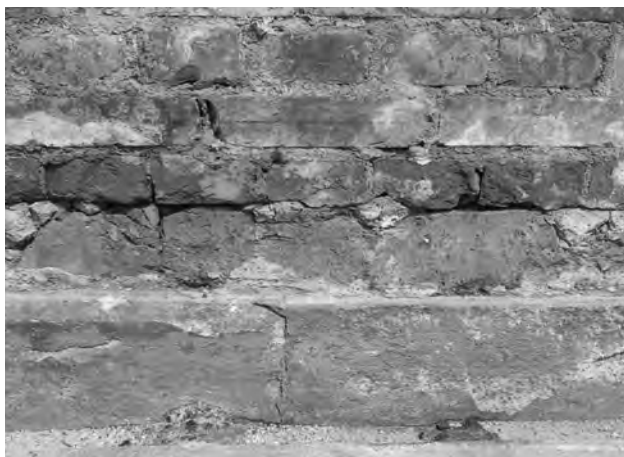
1. 50 区画 東辺内面墨打ち痕跡 (西から)
