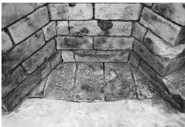
7. 16 暖炉 床面耐火煉瓦「MARUSAN」(北から)
