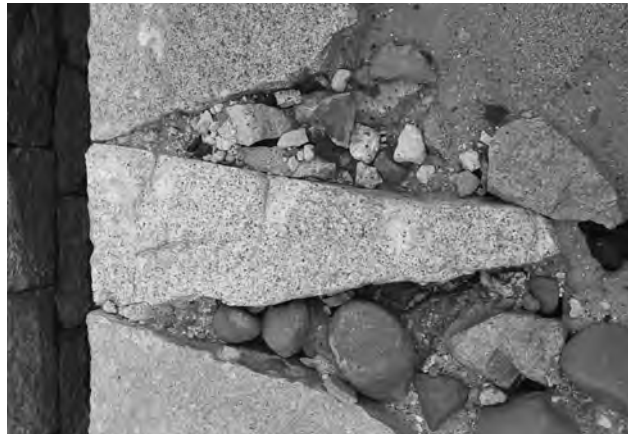
4. 68 石組溝間知石 石材 30 矢穴痕 (南から)
