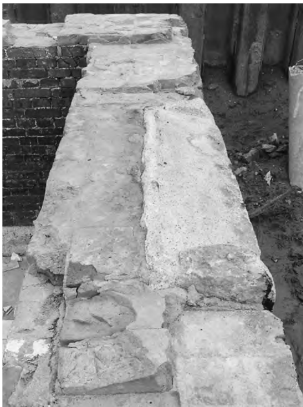
1. 10区画 外周壁南辺上面窓枠石材 (西から)
