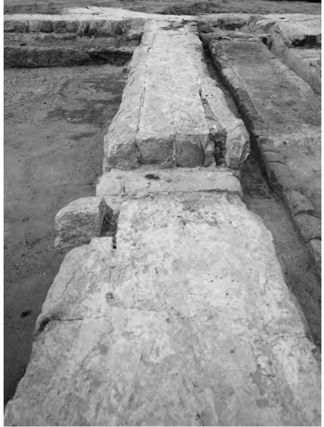
2. 26区画・31通路間 切石基礎(南から)
