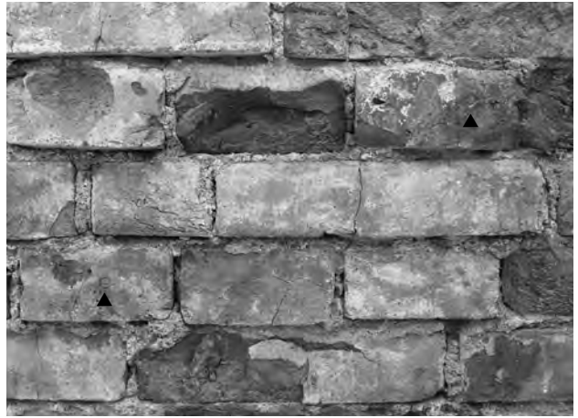
4. 10区画 外周壁南辺内面煉瓦刻印 (▲印) (北から)
