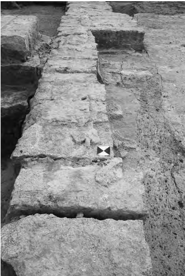
5. 22 玄関・23 区画間 切石基礎 (北から)
