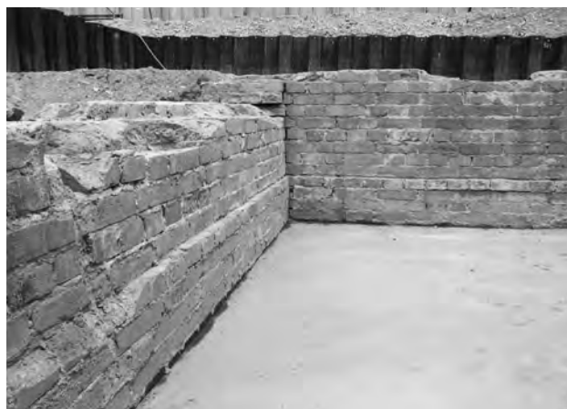
4. 11区画 外周壁北・西辺内面 (南から)
