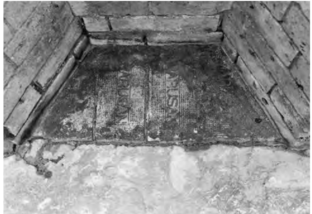
2. 17 暖炉 床面耐火煉瓦「MARUSAN」(北から)
