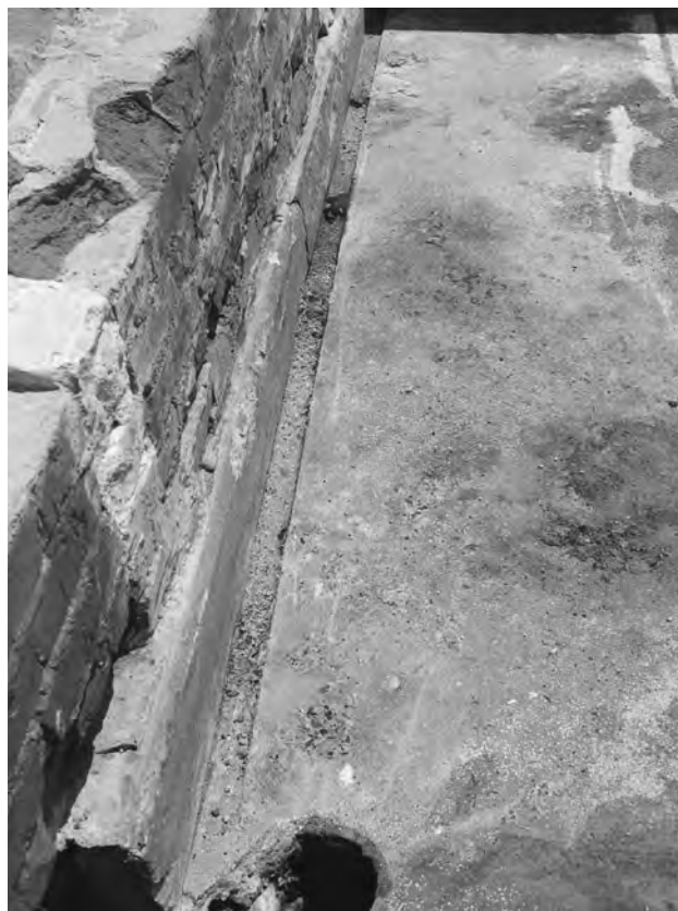
6. 50区画 東辺と床の隙間 (北から)
