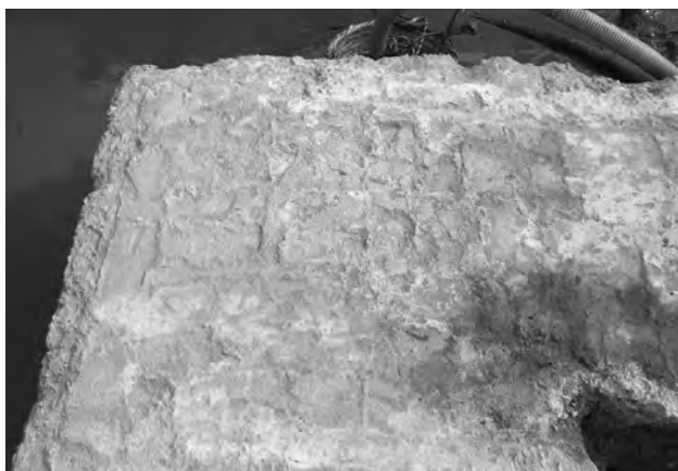
7. 南東隅 コンクリート基礎上面の煉瓦圧痕 (北から)
