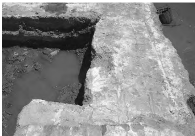
8. 南東隅 コンクリート基礎上面の煉瓦圧痕 (西から)
