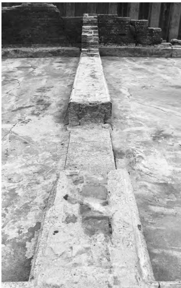
3. 1・2区画間 間仕切り壁と出入口 (南から)
