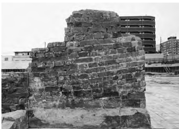
3. 10区画 南辺南北部分 中央棟 20区画方向へ傾斜させる煉瓦積み (東から)
