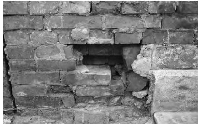
6. 34・35区画間 外周壁北辺内面の間仕切り壁部墨打ち痕跡 (南から)
