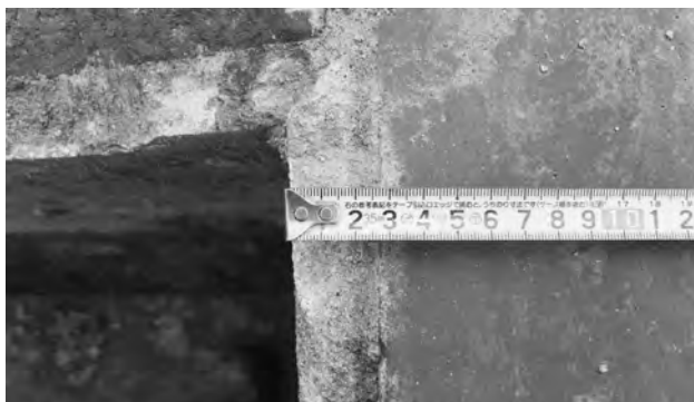
6. 50 区画 南辺東端内面漆喰の厚さ (西から)
