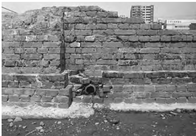
5. 71 土管 南翼外側 (東から)
