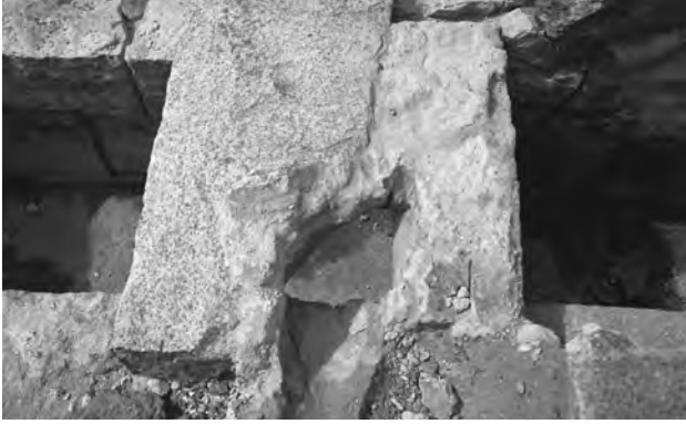
1. 67 土管接続部の 68 石組溝蓋石の穿孔 (北から)
