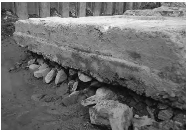
7. 北西隅 コンクリート基礎と栗石 (南西から)
