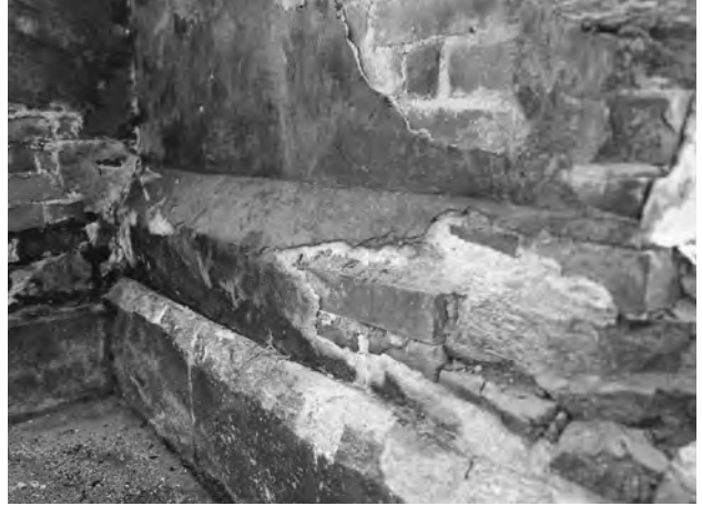
2. 9区画 南東柱東辺漆喰による成形 (北東から)
