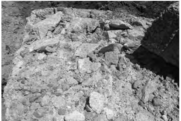
6. 8 区画付近 コンクリート基礎裏面の栗石 (西から)
