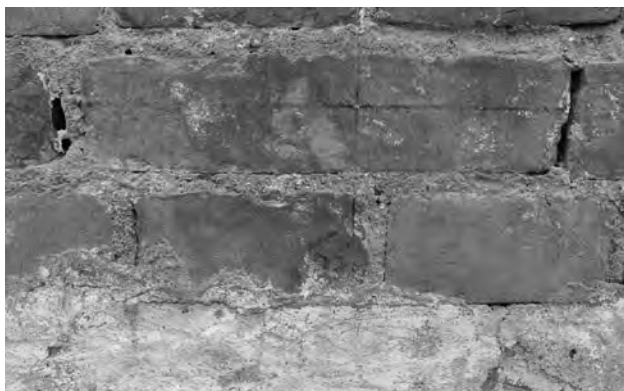
5. 43区画 南辺内面墨打ち痕跡と墨書「15」 (北から)
