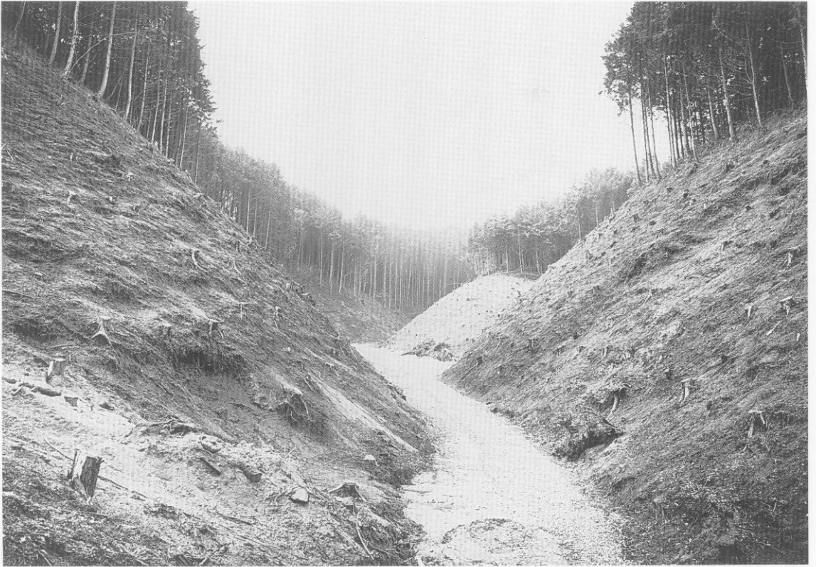
1. 伐採・防災工事後の状況 1
