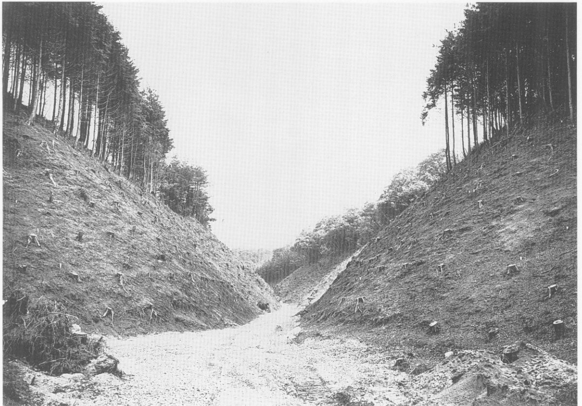
2. 伐採・防災工事後の状況 2
