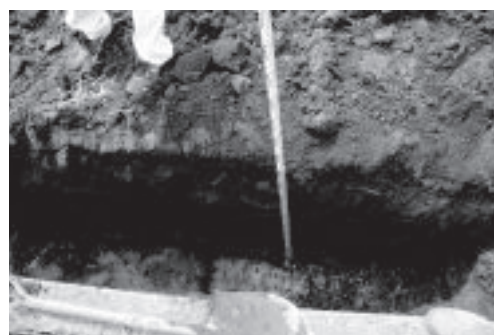
F. 農学部圃場給水管更新工事（北より） 1708
