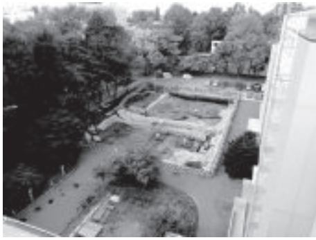
A. 調査状況(遠景:南東より)
