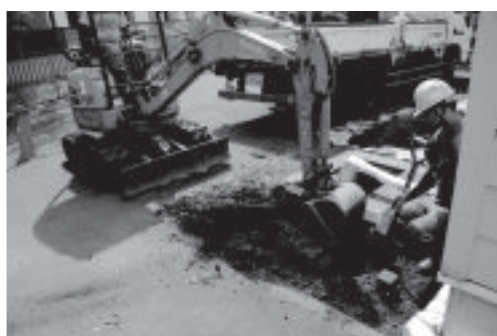
C. 北大病院保育園ポプラ給水管改修工事 （北西より） 1706
