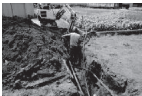
E. 農学部圃場給水管更新工事（南より） 1708
