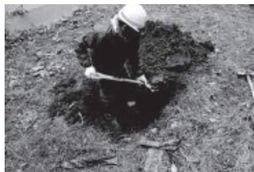
H. 工学部屋外ガス管修理工事（北より） 1712
