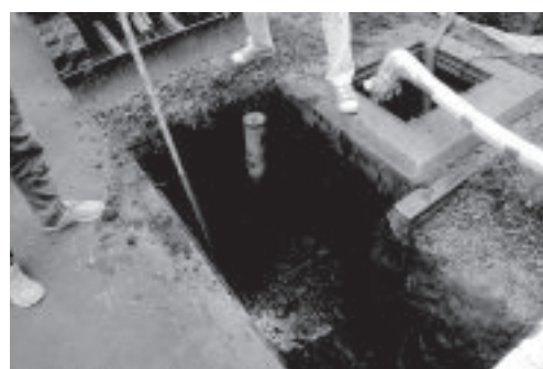
D. 北大病院保育園ポプラ給水管改修工事 （北西より） 1706
