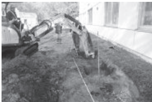
E. ポプラ保育園東側ネットフェンス改修工事 (南より) 1819
