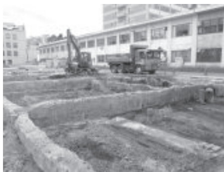
B. 表土はぎの様子(遠景:南東より)
