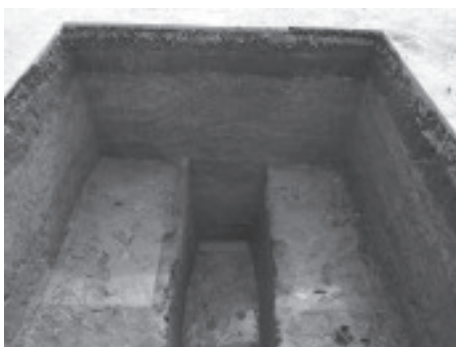
G. TP09南壁の様子(セクション:北より)
