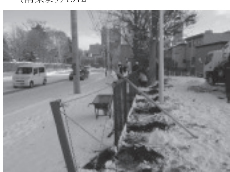
H. 中央第二宿舎フェンス改修工事(西より)1917
