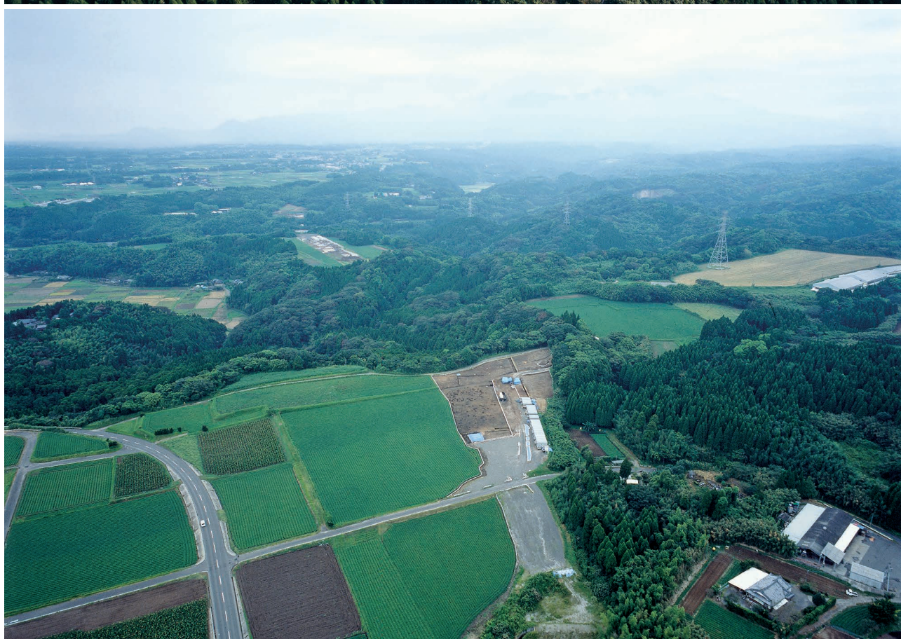
遺跡遠景（上：北方向から 下：東方向から）
