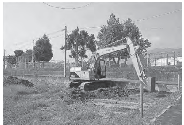
重機による表土掘削状況
